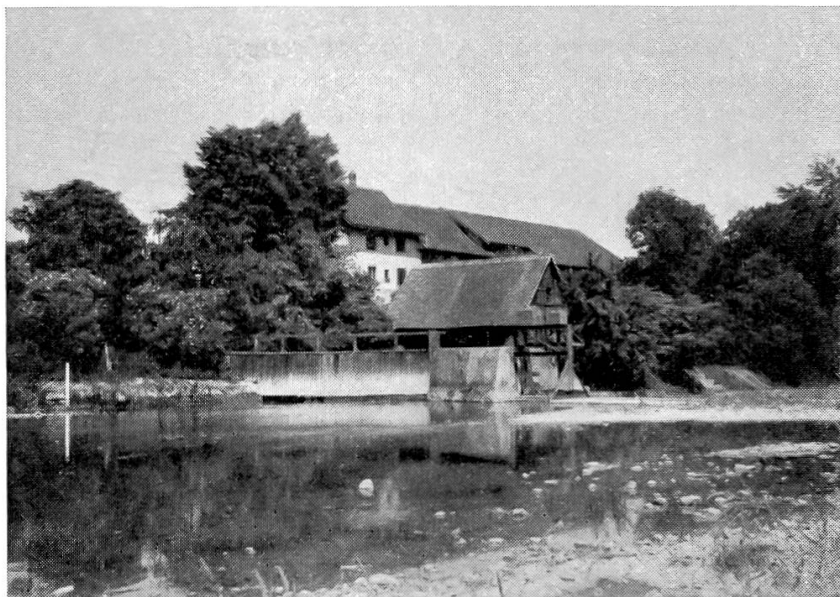
Abbildung 116. Oberwasser des Wehres Neuwelt mit Abzweigung des St. Alban-Teiches und «Wasserhaus», km 22,435. – Das Wehr von Neuwelt leitet bei Niederwasser mit Ausnahme geringer Sickerwassermengen den gesamten Abfluss nach dem St. Alban-Teich oder Neuwelt-Teich genannten Industrie- und Gewerbekanal. Das Gefälle dieses Kanals bis zum Rhein beträgt noch über 20 m und wird von verschiedenen Wasserkraftanlagen ausgenutzt. Bei Brüglingen fließt der Kanal geteilt; ebenso erfolgt die Mündung in den Rhein in zwei verschiedenen Kanälen. (Phot. B. WOLF, Basel.)
