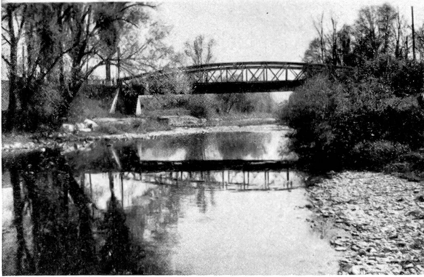
Abbildung 121. Strassenbrücke St. Jakob-Schänzli. – Birs bei Niederwasser. Blick flussaufwärts. Probefassungsstellen F 3 und F 4. – Unterhalb der Holzbrücke Neuwelt wird der Abfluss der vom St. Alban-Teich umflossenen Birsstrecke durch Grundwasser- austritte wesentlich vergrössert. – 14. 4. 1946. (Phot. H. S.)
