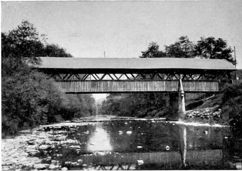
Abbildung 113. Vom BBC-Kanal umflossene Birsstrecke mit Holzbrücke Münchenstein Bei niederem Wasserstand fliesst ausser wenigem Sickerwasser höchstens noch etwas Wasser durch den Fischpass in die vom BBC-Kanal umflossene Birsstrecke. Der Abfluss derselben entstammt dann im wesentlichen den unterhalb des Wehres linksufrig austretenden Grundwasseraufstössen und kann auf etwa 0,2 bis 0,4 m 3 /sec geschätzt werden. — (Phot. B. WOLF, Basel)
