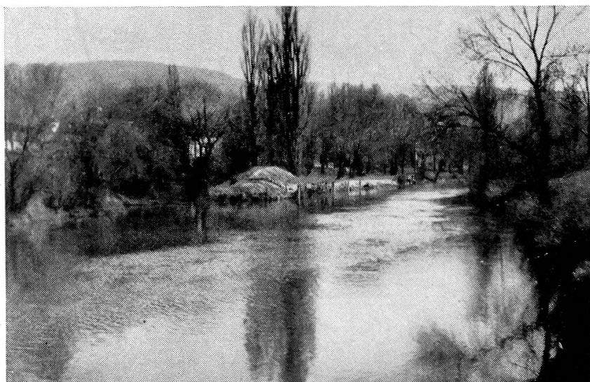
Abbildung 105. Birs mit ehemaliger Wasserrückgabe des Kanals der Metallwerke Dornach. Blick flussaufwärts. km 17,545. – Zwischen der Wasserrückgabe des Kanals der Spinnerei Angenstein und dem Wehr von Dornachbrugg haben sich die Verhältnisse im Laufe der Untersuchungsperiode insofern geändert, als bei den Untersuchungen der 30er-Jahre der Kanal der Metallwerke noch der Energieerzeugung diente, während heute der grösste Teil des Abflusses über das Wehr fliesst. Die Probefassungsstelle A 10 lag deshalb am 17. 8. 1937 im Kanal, während sie 1945–1947 in die Birs verlegt wurde. – Die geringe, heute beim Wehr vom Kanal der Metallwerke noch aufgenommene Wassermenge dient lediglich der Abspülung der Abwässer. Der Kanal ist in seinem heutigen Zustand als offenes Abwassergerinne zu betrachten. – Etwas unterhalb der ehemaligen Wasserrückgabe des Kanals beginnt die durch das Wehr von Dornachbrugg gestaute Birsstrecke, an deren Ende die Probefassungsstelle A 12 liegt. 26. 3. 1946 (Phot. H. S.)
