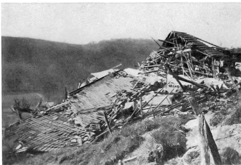
Abbildung 36. Untere Teilrutschung. Doppelwohnhaus und Weinthagstrasse von Osten. Verschiebung der Weinthagstrasse durch Verschiebungskluft zwischen «Doppelwohnhaus»-Scholle und «Depressions»-Scholle. Trümmer des Doppelwohnhauses infolge Überschiebung des Wulstes gegen die Talseite gekippt.
