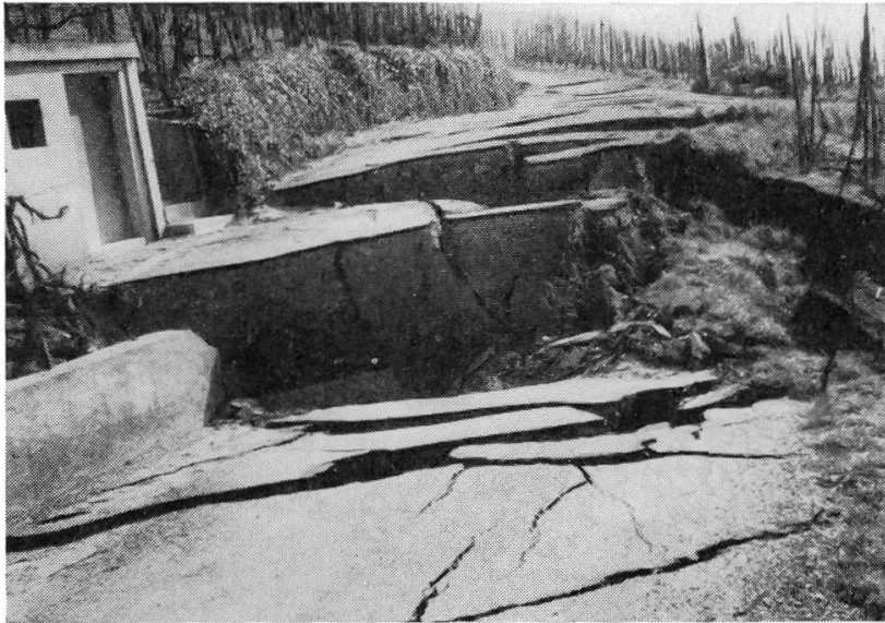
Abbildung 28. Abriss Ost der mittleren Teilrutschung. Südöstliche, seitliche Abriss- und Verschiebungsspalte bei Beginn der Rutschung. Gerätehäuschen (links auf dem Bilde) noch nicht zerstört. Photo DIERKS, 8. April 1952, vormittags
