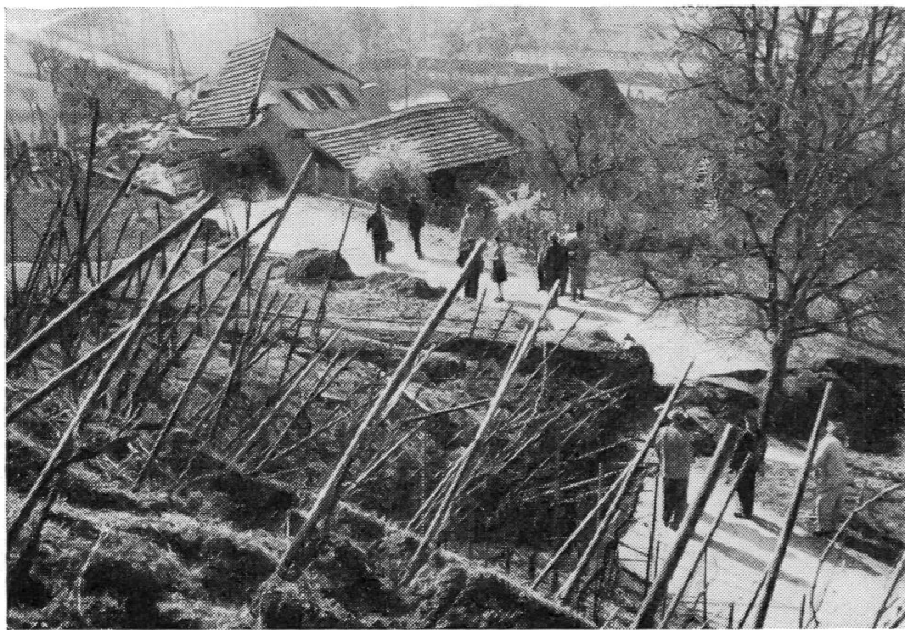
Abbildung 33. Untere Teilrutschung. Verschiebungsspalte zwischen «Doppelwohnhaus»-Scholle einerseits und «Bunker»-Scholle bzw. Vorgelände andererseits an der Weinhagstrasse. Hinten: «Doppelwohnhaus»-Scholle mit Doppelwohnhaus. Vorne links: «Bunker»-Scholle. Vorne rechts: Vorgelände. Photo DIERKS, 8. April 1952, etwa 11 Uhr
