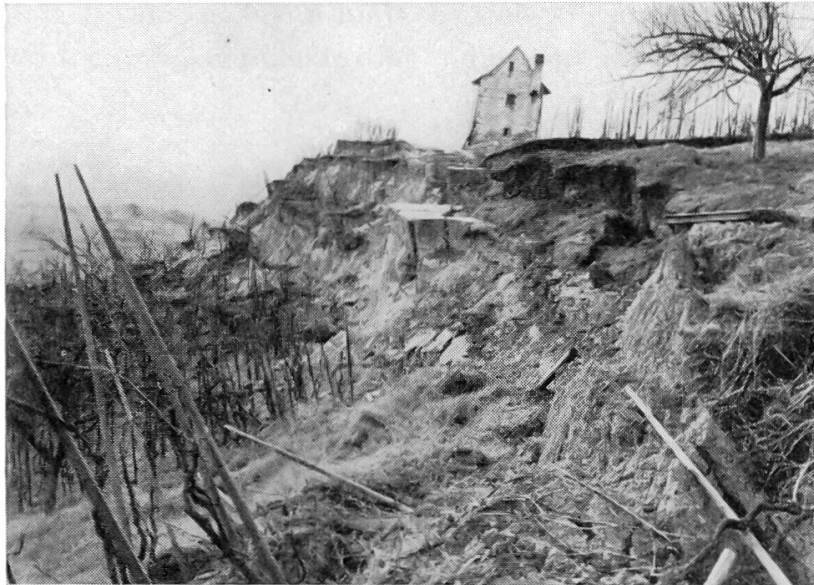
Abbildung 24. Abriss West der mittleren Teilrutschung. Abriss südöstlich des Bannwart- hauses nach Stillstand der Rutschung. Photo Polizeikommando Baselland, 10. April 1952, nachmittags
