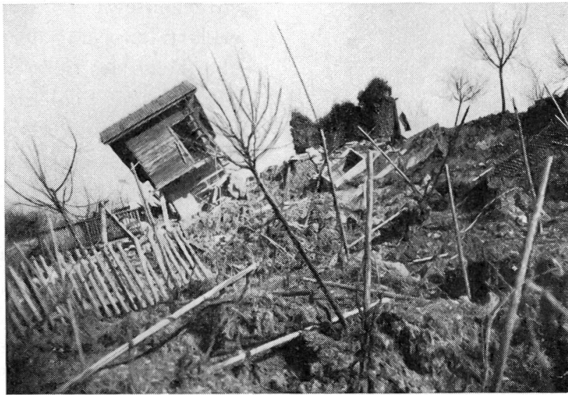
Abbildung 22. Abriss West der mittleren Teilrutschung. Durch mittlere Teilrutschung abgerissene Wulst der oberen Teilrutschung mit talwärts schiefgestelltem Gartenhaus. Blick von Südosten. Photo BERTOLF, Basel, 8. April 1952, vormittags
