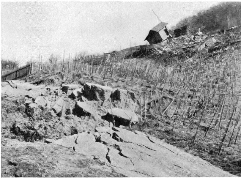
Abbildung 26. Mittlere Teilrutschung. Durch Drehbewegung gegen Hang geneigte Rutschschollen am Neusetzweg. Verschiebungsspalte in der Fortsetzung des seitlichen Abrissrandes der unteren Teilrutschung (vordere Scholle später von unterer Teilrutschung erfasst!). – Oben: Durch Abriss der mittleren Teilrutschung zerbrochener Wulst der oberen Teilrutschung mit schiefgestelltem Gartenhaus.
