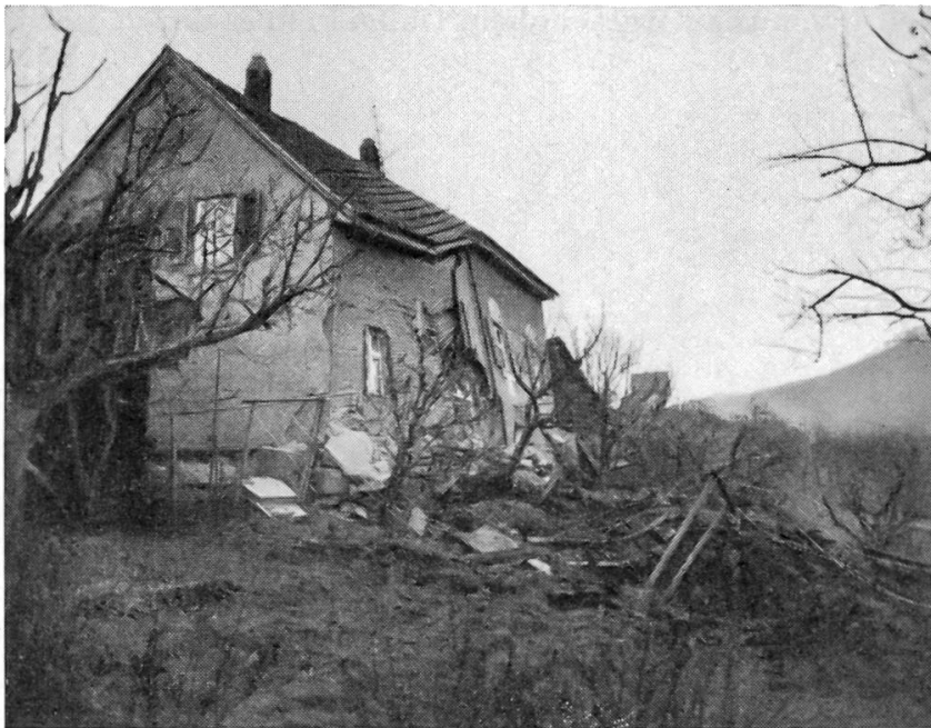
Abbildung 35. Untere Teilrutschung. Doppelwohnhaus und Wulst der unteren Teilrutschung nach Beginn der Bewegung. Photo BERTOLF, 8. April 1952, etwa 6 Uhr
