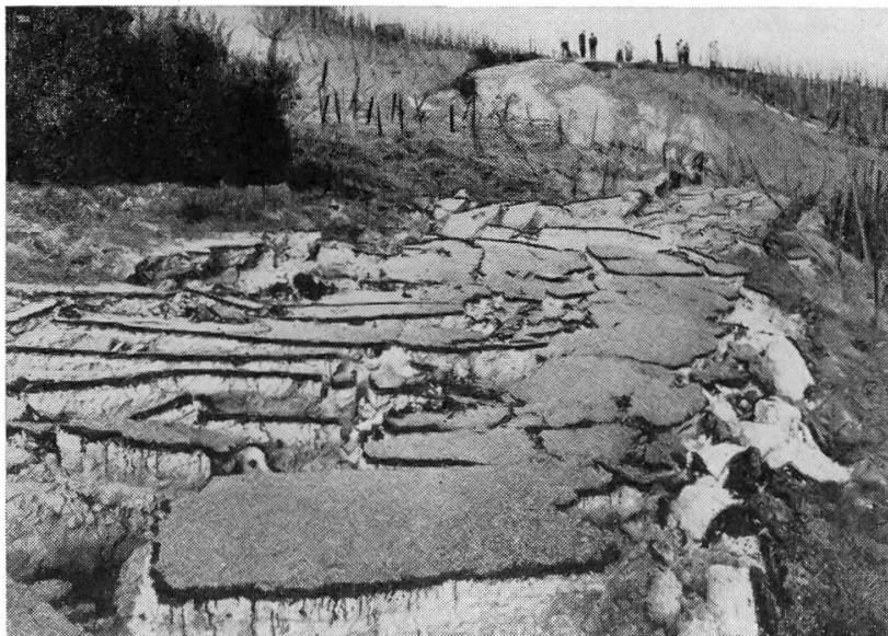
Abbildung 29. Abriss Ost der mittleren Teilrutschung. Südöstliche seitliche Abriss- und Verschiebungsspalte nach Stillstand der Rutschung. Photo Polizeikommando Baselland, 10. April 1952, nachmittags
