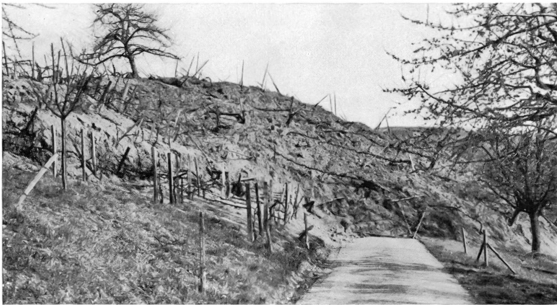
Abbildung 34. Untere Teilrutschung. Überschiebung des Wulstes der «Bunker»-Scholle auf die Weinhagstrasse. Photo Polizeikommando Baselland, 9. April 1952, nachmittags
