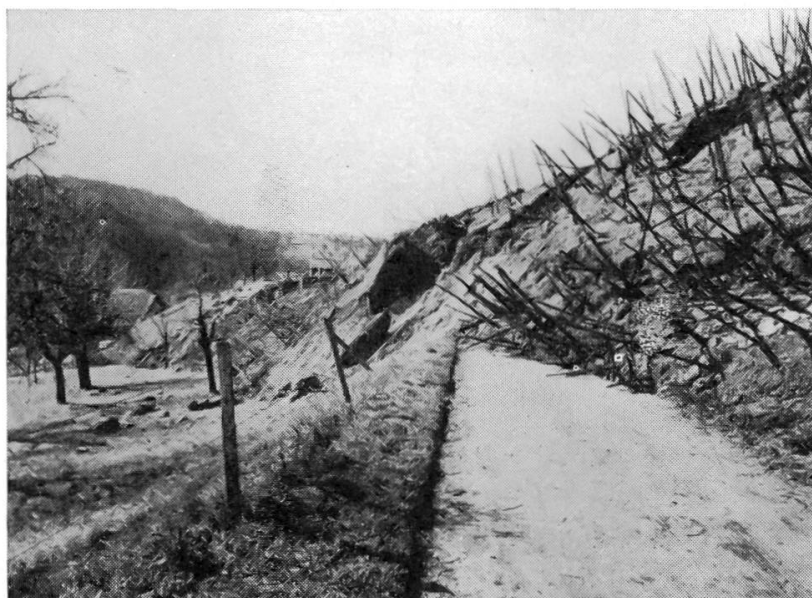
Abbildung 27. Mittlere Teilrutschung. Überschiebung des Wulstes der «Stein»-Scholle auf die Weinhagstrasse am südöstlichen Rand der Rutschung. Photo Polizeikommando Baselland, 9. April 1952, vormittags
