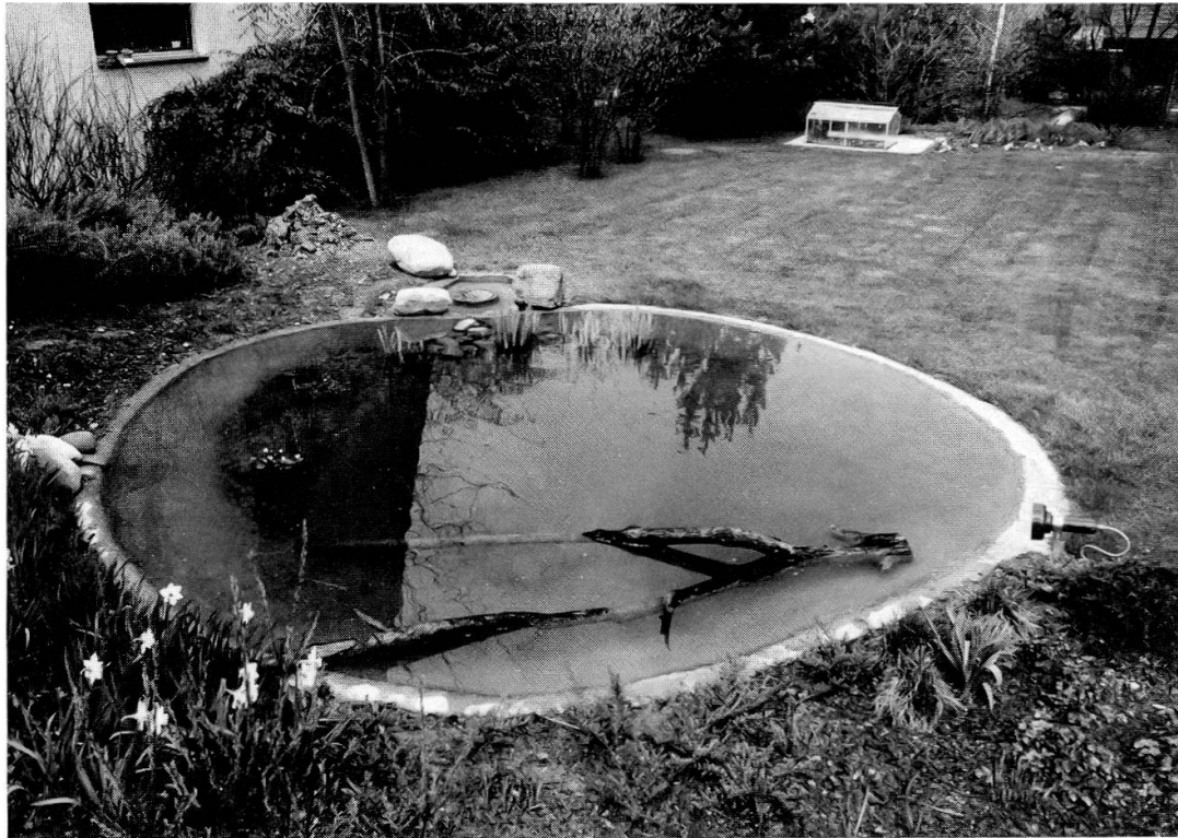
Abb. 6: Gartenteich in Beton ausgeführt. Foto: F. LABHARDT.
