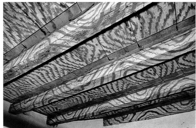
Abb. 9: Detailaufnahme einer mit Holzmaserierung bemalten Balkendecke im Gastzimmer, im dritten Obergeschoss des Wohnturmes. (Foto Bildarchiv Kantonale Denkmalpflege, Liestal)
