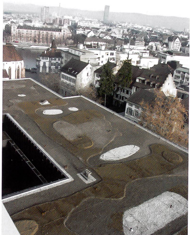
Abb. 8: Musterdachbegrünung mit verschiedenen Bodensubstraten aus der Region auf dem Universitätsspital Basel nach der Neueinrichtung 2003. Photo: Stephan Brenneisen.
