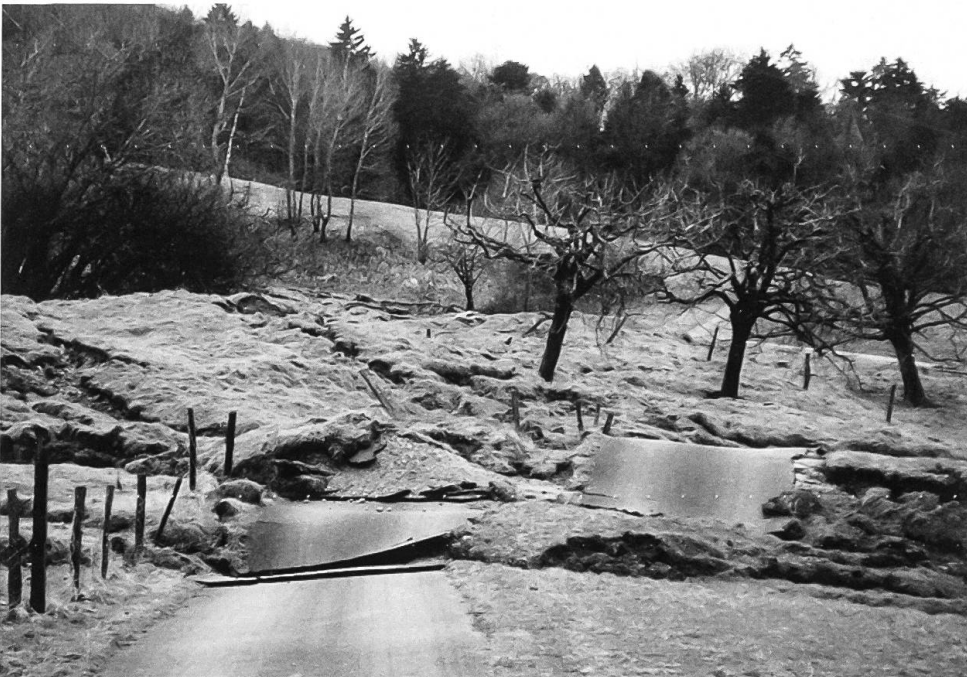
Abb. 3: Rutschung «Matt» oberhalb Wintersingen, Frühling 1999. Die nach einem schnee- und regenreichen Winter spontan ausgelöste, mittel- bis tiefgründige Lockermaterialrutschung ist heute weitgehend ruhig. Foto: Gemeinde Wintersingen.
