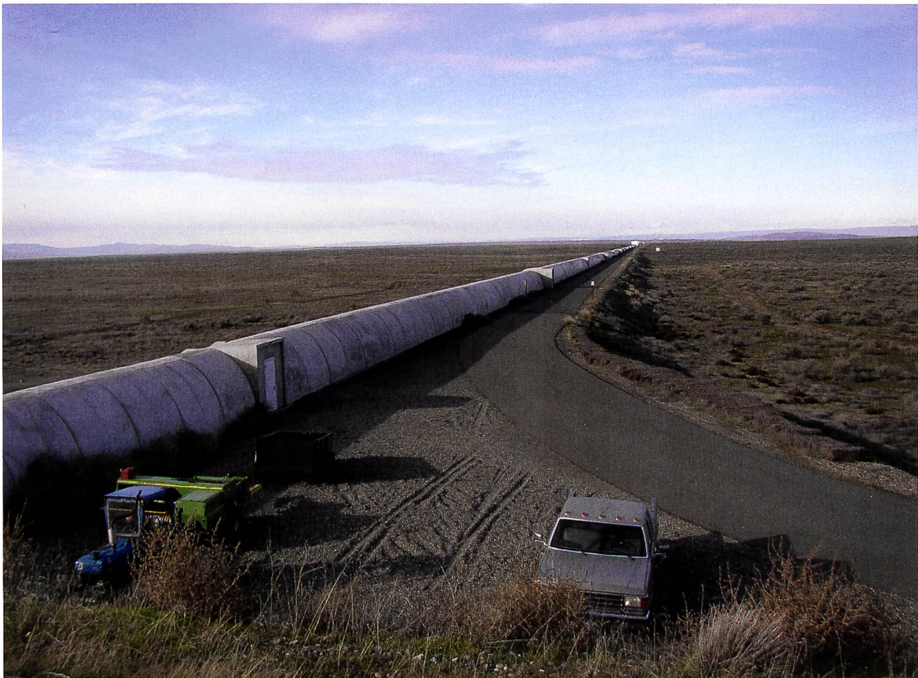
Abb. 8: Nördlicher Arm des LIGO Hanford Observatoriums für Gravitationswellen im Bundesstaat Washington nahe der Westküste der USA. Seine beiden Arme stehen senkrecht aufeinander und haben eine Länge von je 4 km (Quelle: https://de.wikipedia.org/wiki/LIGO ).
