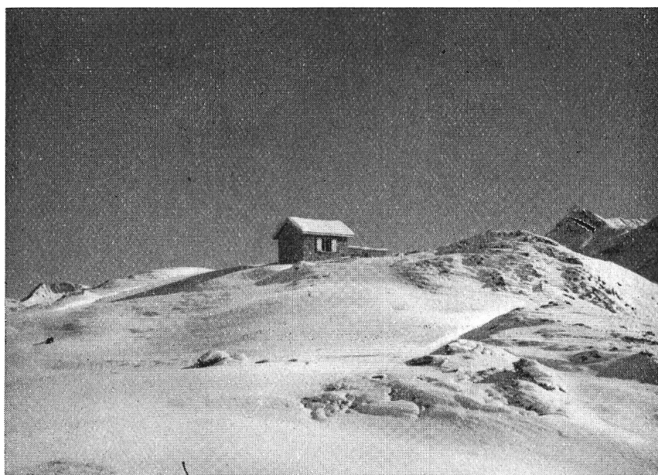
Der neue Beobachtungsstützpunkt auf der Kuppe des Tschuggen (2040 m).
