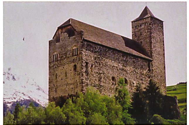
Abb. 7: Ansicht der Burg im Jahr 1994. Sicht auf die Ost- und Nordfassade. Die damals noch kleinen Bäume nahe der Fassade wurden später teilweise gefällt, da sie die Benutzbarkeit der Brutnischen für die Dohlen behinderten. Ausserdem schädigte das Wurzelwerk die Mauerfundamente. Bereits im Folgejahr nach der Fällung der Bäume stieg die Anzahl der Bruten in der Nordfassade stark an. (Foto: W. Bürkli).
