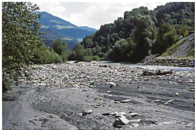
Abb. 12: 1994. Linksufrig wurde eine alte Deponie mit Blocksatz unter Baggereinsatz im Gerinne gegen Seitenerosion gesichert. Die Kiesflächen und Feinsedimentablagerungen sind vegetationsfrei. Der Glenner umfließt beidseitig die Felsinsel.
