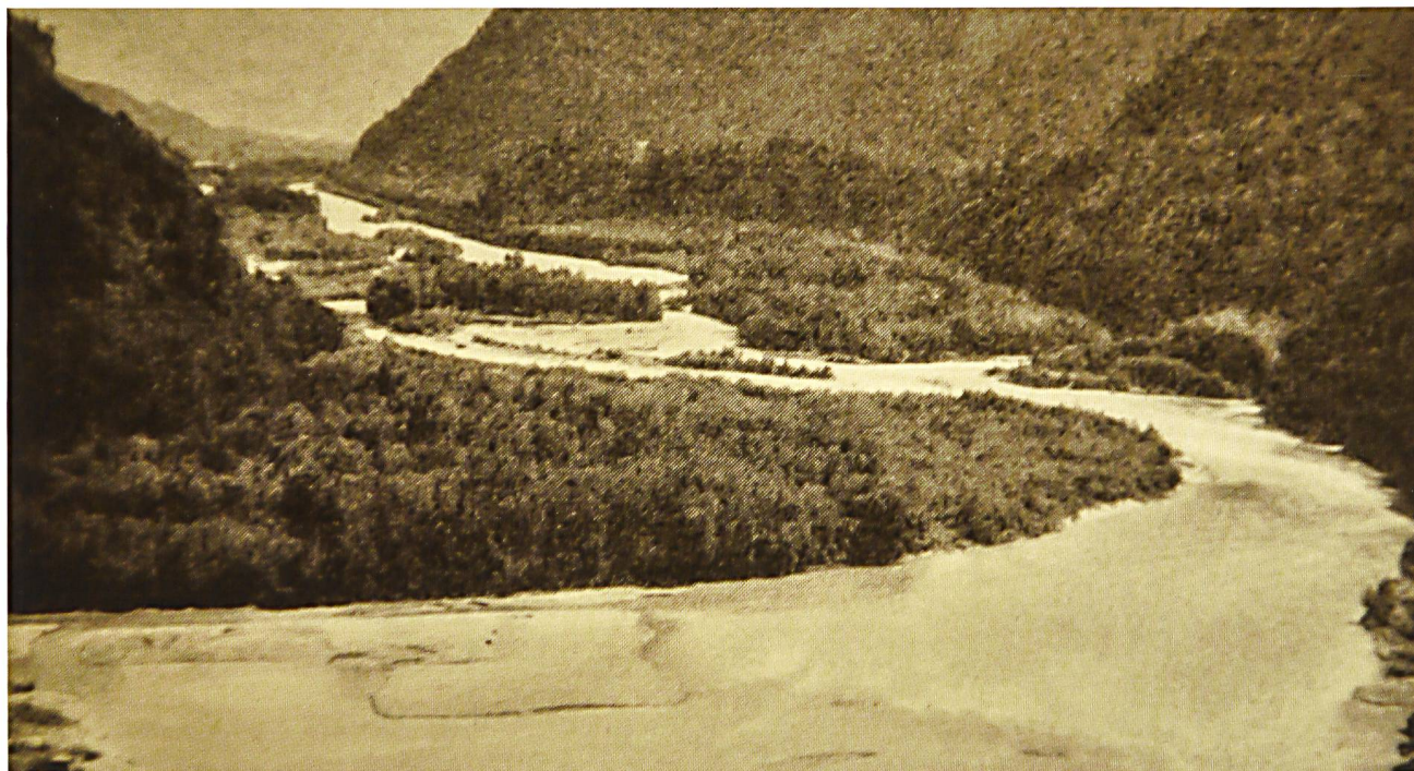
Abb. 31: Hinterrhein bei Rhäzüns 1975 mit Blick nach Süden flussaufwärts. (Foto aus MÜLLER 1975). Man beachte die Kiesentnahmen in der vegetationslosen Aufweitung im Vordergrund; dahinter die «Isla Bella».
