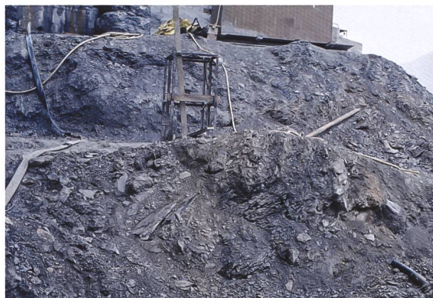
Abb. 3: Baugrube Chesa Corviglia (Baubeginn 1980), Aushub in der chaotischen, verflochtenen Sturzmasse (Foto: Ch. Schlüchter).
