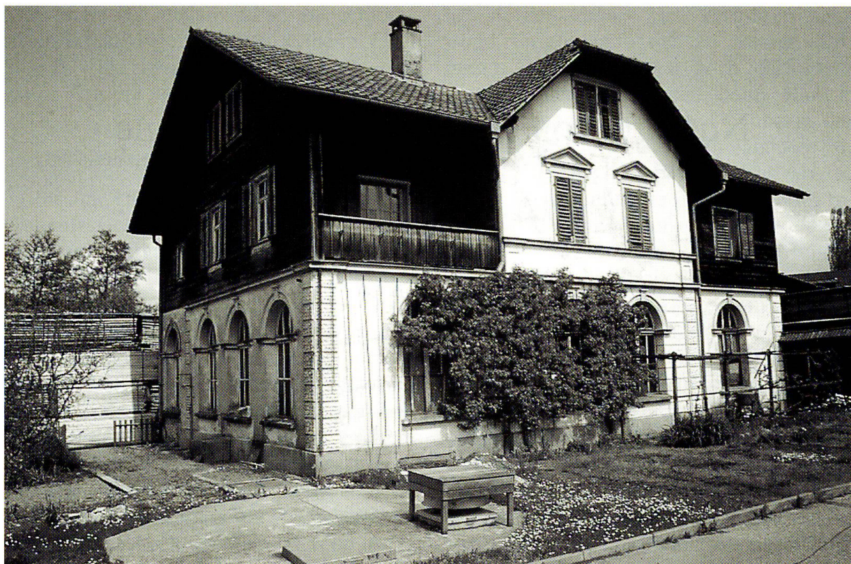
Abb. 2: Das letzte kleine Elektrizitätswerk in der Sägerei Büzwil ist heute noch in Betrieb. In den Schächten vor dem ehemaligen Kraftwerkgebäude wird eine Turbine vom Wasser aus den Wili-stattweihern angetrieben.
