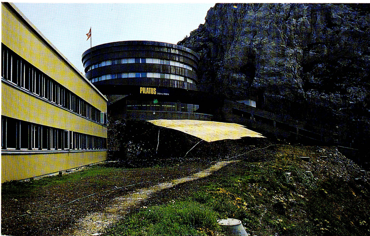
Abb. 5: Die wiederbegrünte Fläche einen Monat nach der Einsaat alpiner Grassamen 1994 (die Hangflächen wurden mit Jute gedeckt).
