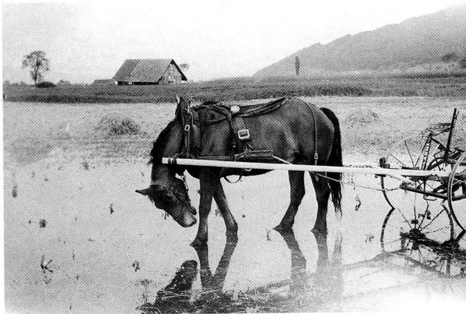
Abb. 3: Rückstau und Überflutungen des Kottwiler Moos. Foto um 1950.
