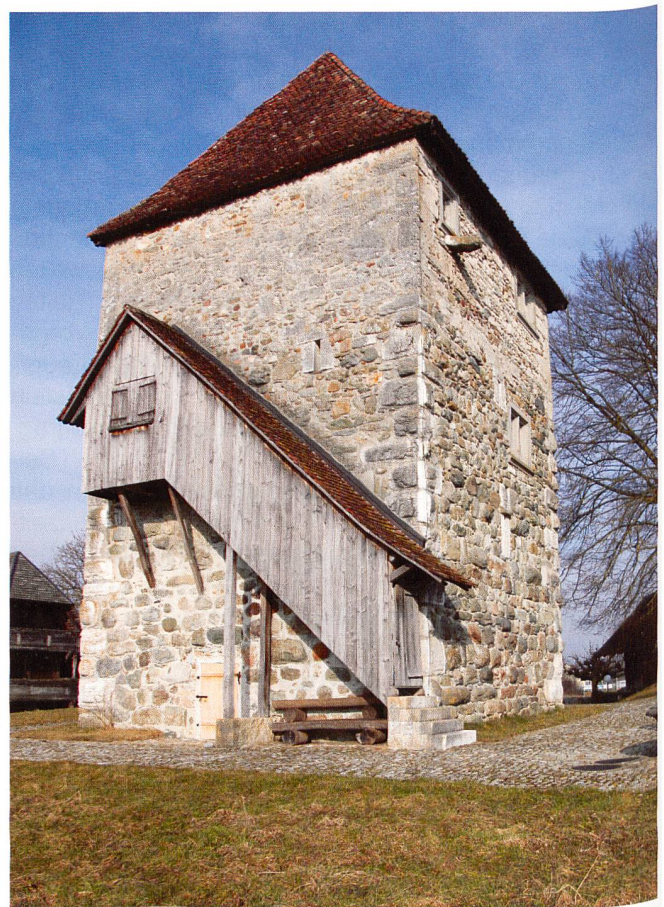
Abb. 1: Burgturm von Halten, von Süden, Mauern bis über den Hocheingang aus der Bauzeit um 1200, oberes Stockwerk von 1543 aus Tuffstein und Bruchsteinen, Dach neuzeitlich
