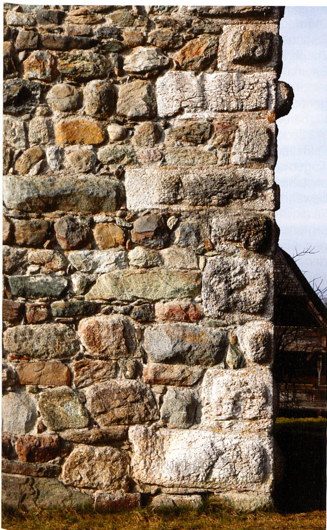
Abb. 2: Ausschnitt der Südostfassade des Burgturms von Halten, Findlingsmauerwerk und Eckverband aus Kalksteinquadern
