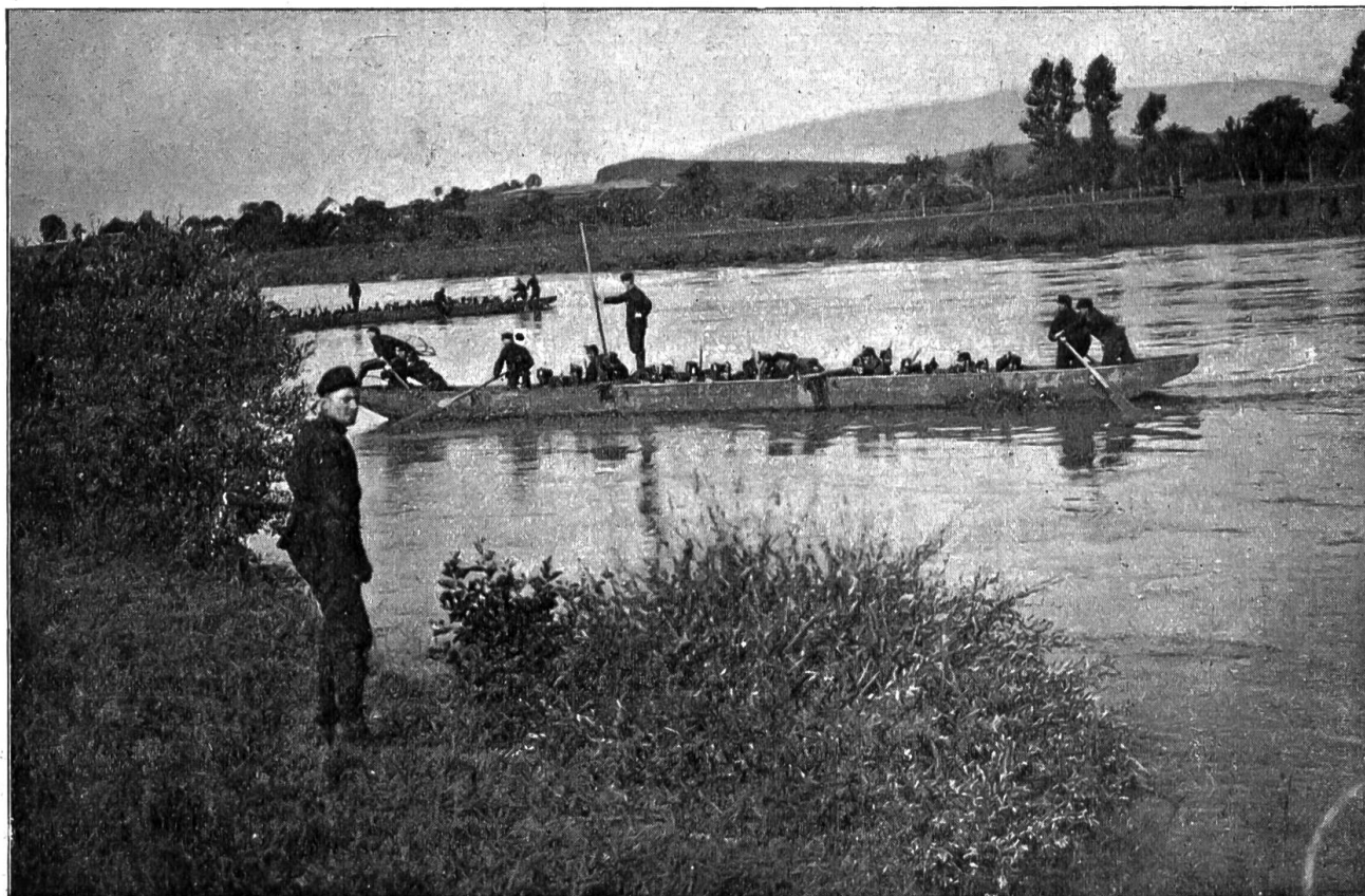
Aus der Grenzbesetzung von 1914. Uebersetzen eines schweizer. Infanterie-Bataillons durch Kriegsbrückenabteilung 3.
