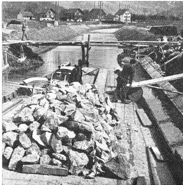
Ein großer Nauen fährt in den Kanal ein. Er bringt Steine vom Lopper, mit welchen die Kanalufer ausgemauert werden
