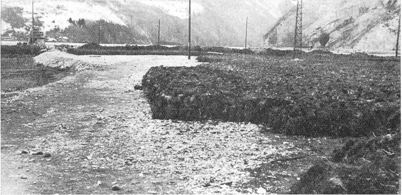
Dieses Bild zeigt die verschiedenen Arbeitsetappen. Links sieht man ein Stück des unbearbeiteten Riedes, in der Mitte die aufgeschüttete Gesteinsauflage, rechts die inzwischen getrocknete, aufgestockte Erde, welche aus dem See gehoben worden ist
