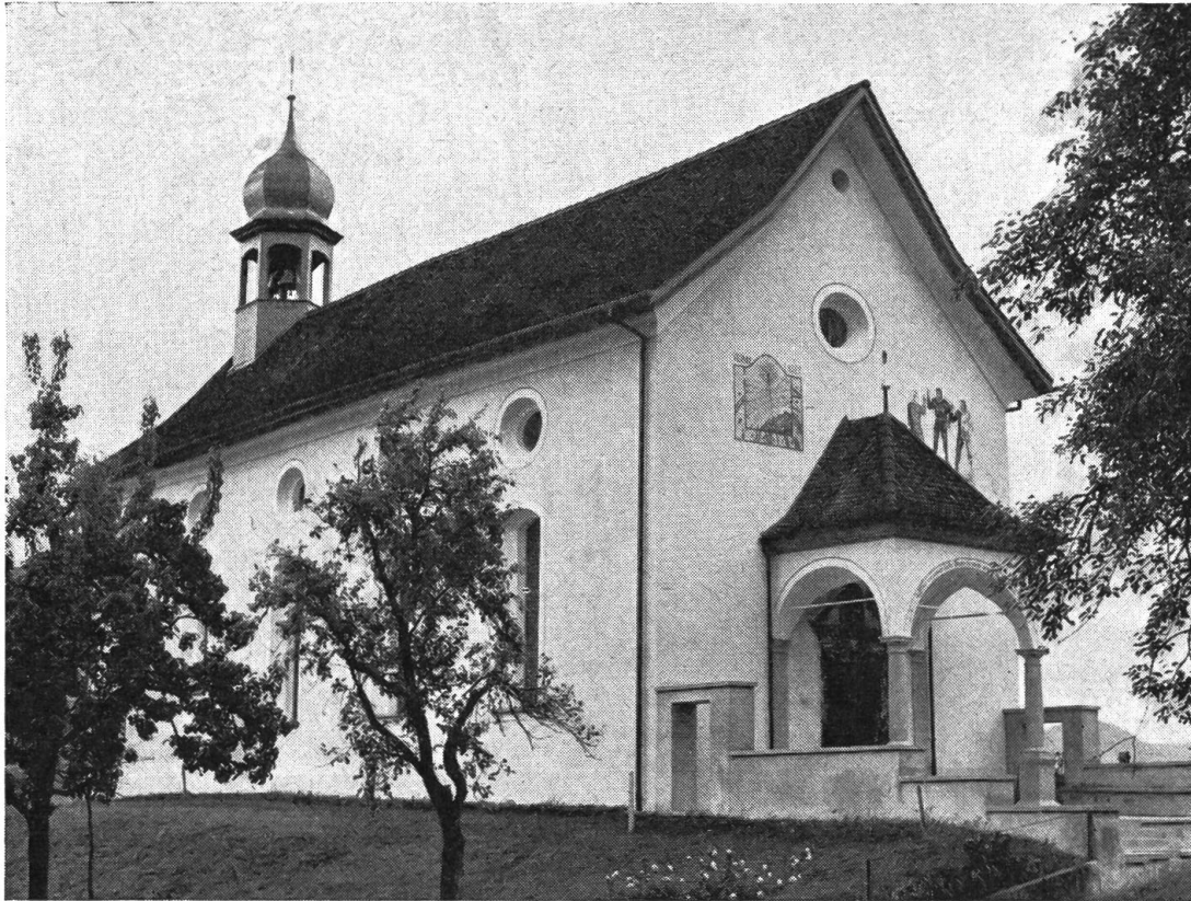
Die Ridli-Kapelle mit den drei Eidgenossen und der Sonnenuhr über dem Vorzeichen. In die zwei Seitenportale zum Vorplatz sind inzwischen hübsche Schmiedeisenegger eingesezt worden.
