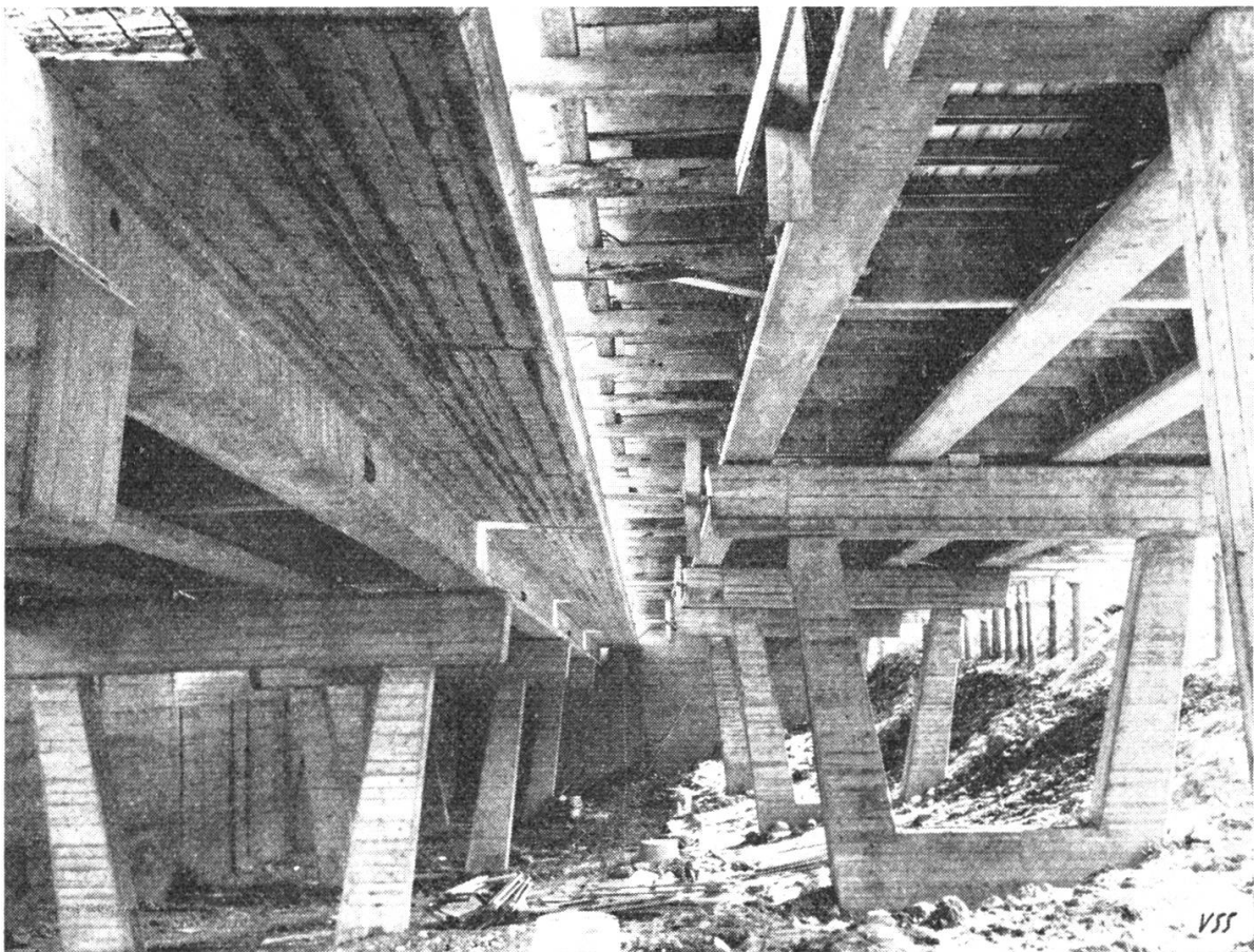
Die elegante, vorfabrizierte Zwydenbrücke soll den rutschigen Grund möglichst wenig belasten.
