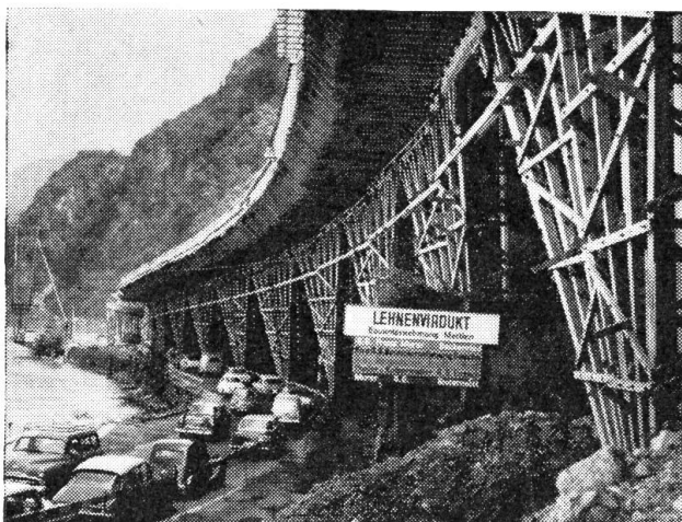
Lehnenviadukt Hergiswil. Ganz im Vordergrund sieht man die Verbreiterung des Viadukts, bedingt durch die Abfahrt nach Hergiswil.
