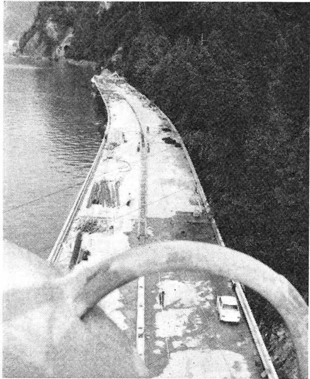
Vom hohen Betonturm aus über Lehnenviadukt und Lopperviadukt. Foto S. Diener
