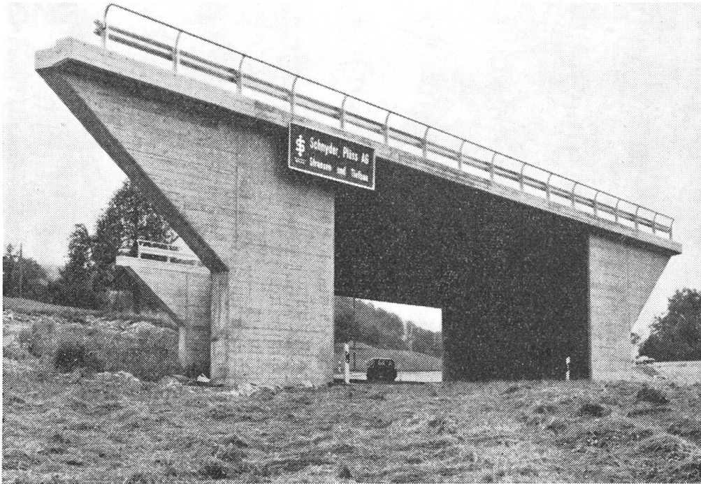
An der Autobahn gegen Beckenried wird fleißig gearbeitet auch wenn es für den Laien nicht so spektakulär aussieht wie im vergangenen Jahr. Inmitten grüner Matten entstehen Viadukte und Stützmauern. Foto A. Odermatt
