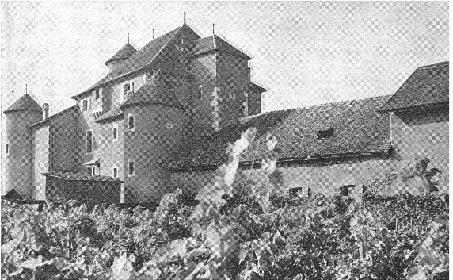
Die ehemalige Johanniterkomturei von Compiègne wurde mit Unterstützung des «Schweiz. Heimatschutz» sehr gediegen renoviert.
