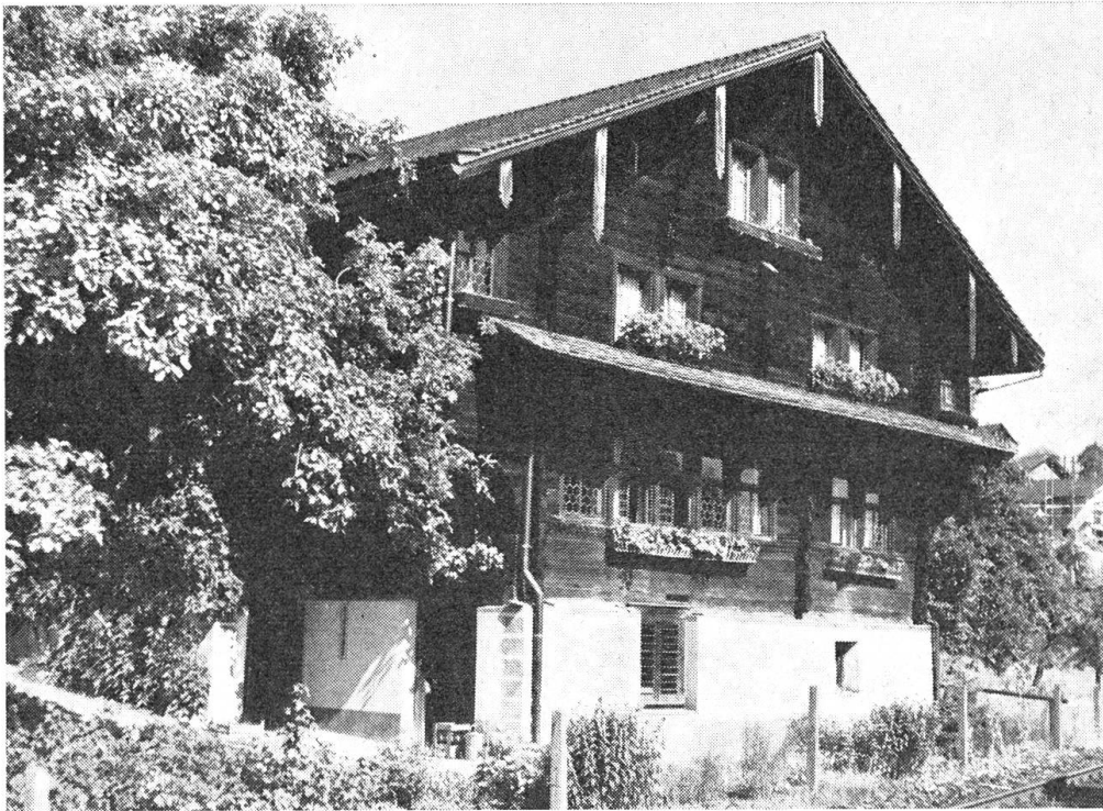
Foto J. Brühwiler
