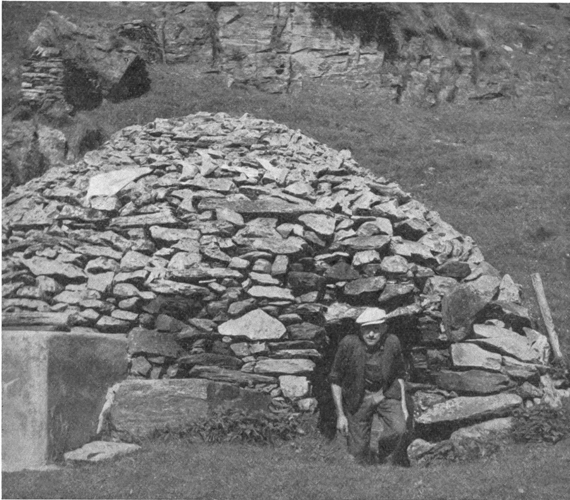
Der aus Trockenmauerwerk gewölbte Milch Keller von San Romerio zeigt, wie die frühgeschichtlichen Wohnbauten ausgesehen haben.
