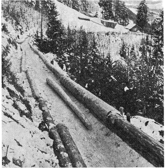
Der Reistweg war früher eines der wenigen Mittel, das Holz zu Tal zu bringen. Da die Beschädigung der Stämme gross war, wird bald kaum mehr ein Reistweg aufrecht erhalten werden.
