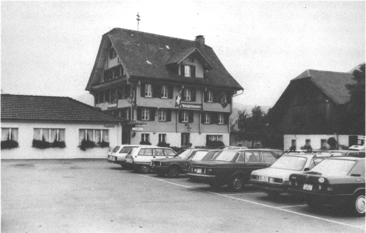
Das Restaurant Schützenhaus, das in den letzten Jahren restauriert und erweitert wurde. Heute sind es nicht mehr Pferdefuhrwerke, sondern «Stahlrösser», die den asphaltierten Platz vor dem Schützenhaus belegen.
