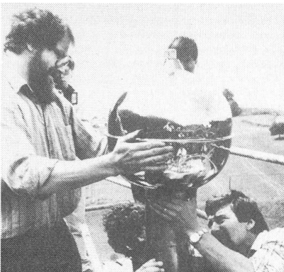
10. Starke Föhnstürme haben dem Kirchturm von Emmetten stark zugesetzt. Deshalb musste er restauriert werden. So bekam der Turm auch ein neues Turmkreuz, das von Hansueli Baumgartner aus Beckenried geschmiedet wurde. Bevor das Kreuz eingesetzt werden konnte, musste die Kugel mit Dokumenten gesetzt werden.
