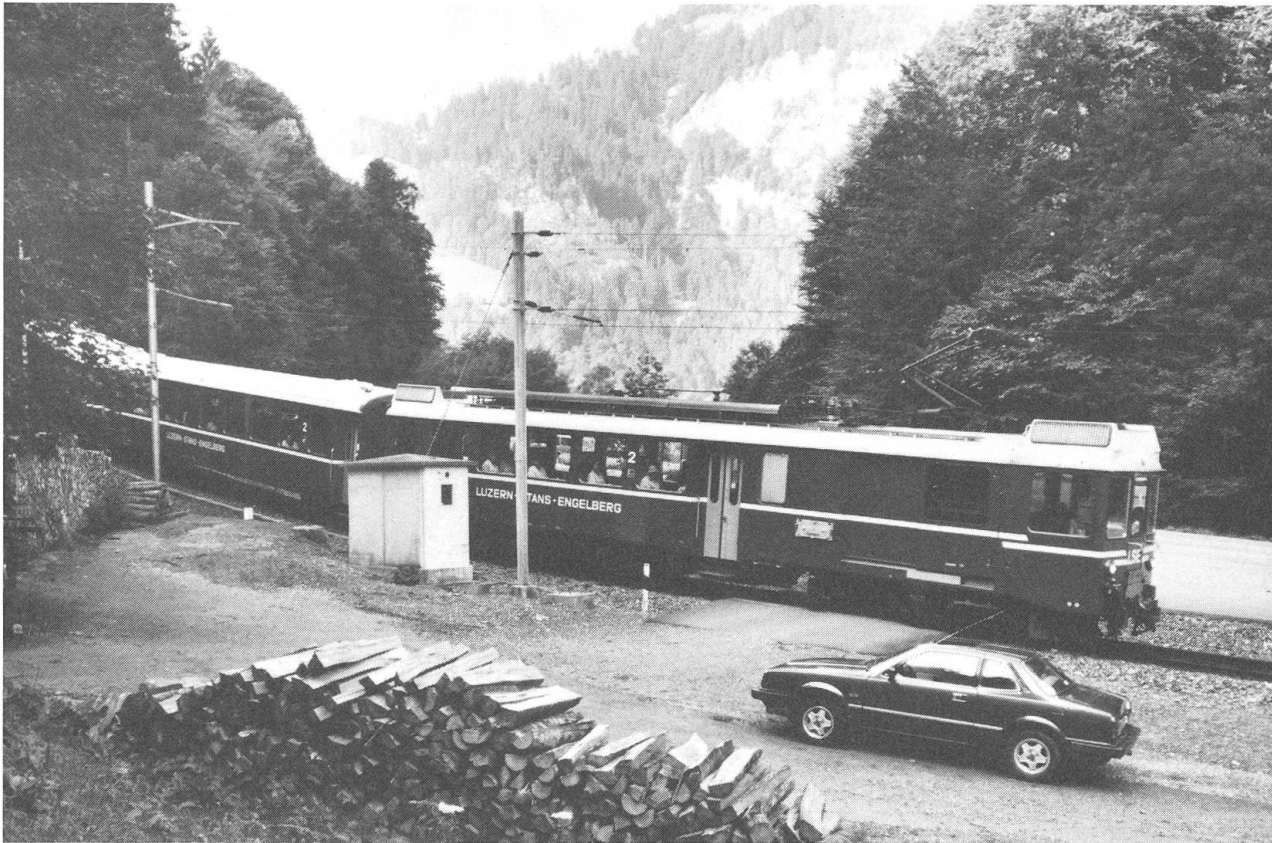
Nach der Verlegung der Strasse die Stelle, an der die Strassenbrücke jeweils hochgekurbelt wurde.
