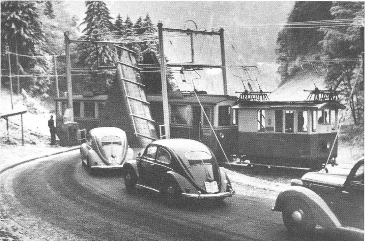
Die Klappbrücke bei Grünenwald, die bis 1961 in Betrieb war. Bei der Durchfahrt eines Zuges musste die Strassenbrücke hochgeklappt werden. Im Bild eine der alten Berglokomotiven, die einen Adhäsionstreibwagen über die Zahnstangenstrecke schiebt.
