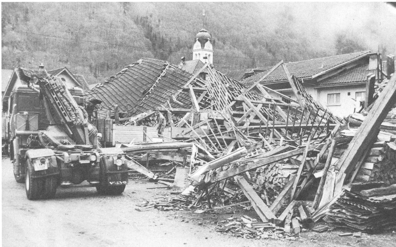
Kurzen Prozess machte der Sturm mit der Lagerhütte der Holzwollefabrik in Wolfenschiessen und zerlegte sie in Einzelteile.
