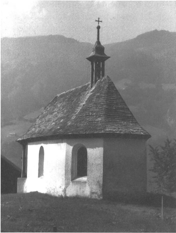
Kapelle Bettelrüti vor der Renovierung.
