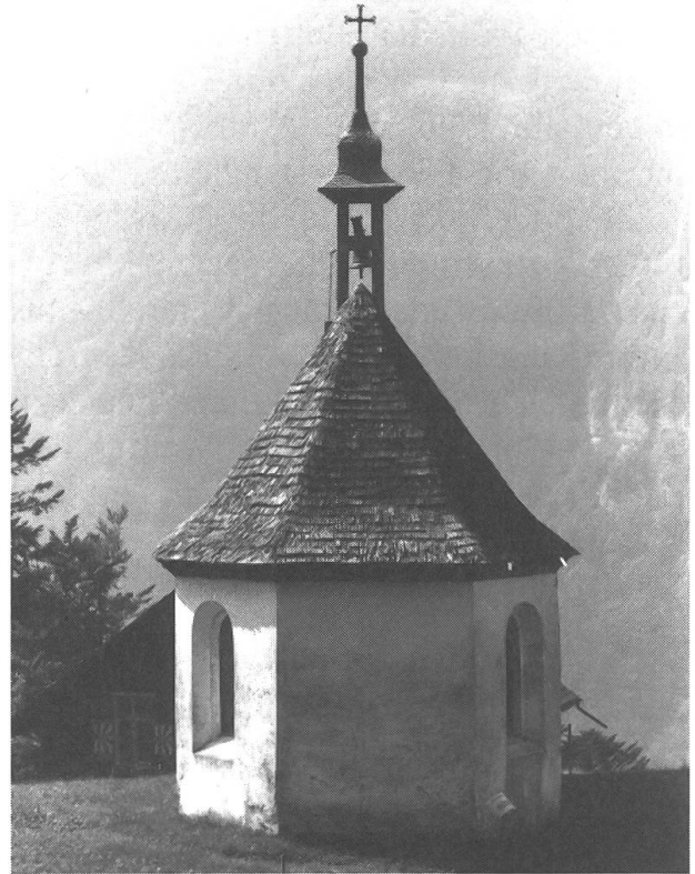
Kapelle, die für Bruder Scheuber gebaut wurde, im alten Zustand.
