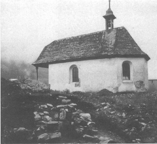
Sondierschnitt in Nord-Süd-Richtung, in dem man auf die ersten Mauerreste stiess.
