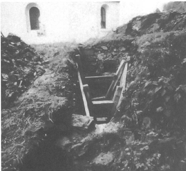
Freigelegtes Bruchsteinmauerwerk der Kapelle mit Tuffsteinfenstergewandung.
