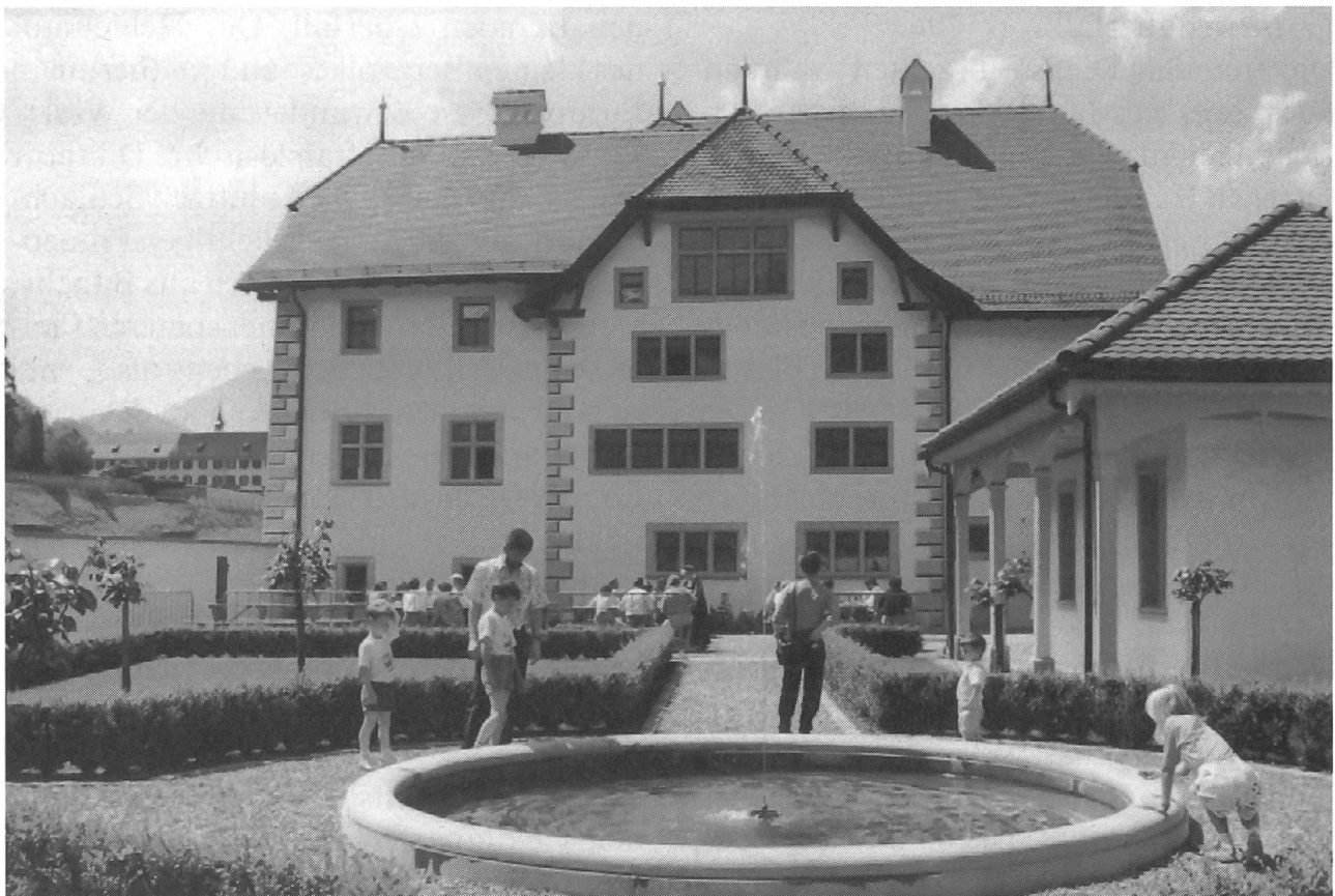
Winkelriedhaus von Osten. Der Mittelteil der Fassade unter dem gewalmten Giebel deckt den Urbau ab, ein Fachwerkhaus, das um 1456/57 errichtet wurde. Der Barockgarten wurde nach vergleichbaren Vorbildern rekonstruiert.
