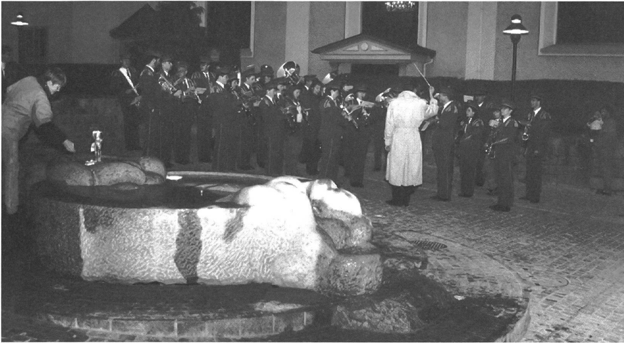
9. Stimmungsvolle Hergiswiler Dorfplatzeinweihung. Mit einem vorweihnachtlichen Dorffest wurde der in umfangreichen Bauarbeiten neugestaltete Dorf- und Kirchenplatz eingeweiht. Sinn und Zweck der Neugestaltung, den Platz zum Ort der Begegnung werden zu lassen.
