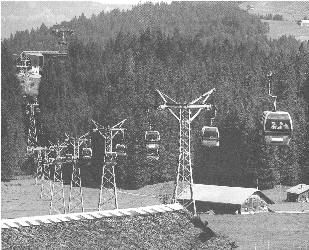
Wie Hagpfosten stehen die Gondelbahnstützen im Alpboden Untertrübsee.
