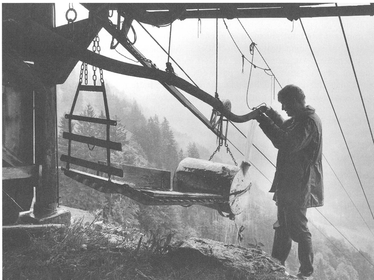
So wird in der Brändlen Wasser eingefüllt, damit das obere Bähnchen das untere Bähnchen hinaufzieht.
