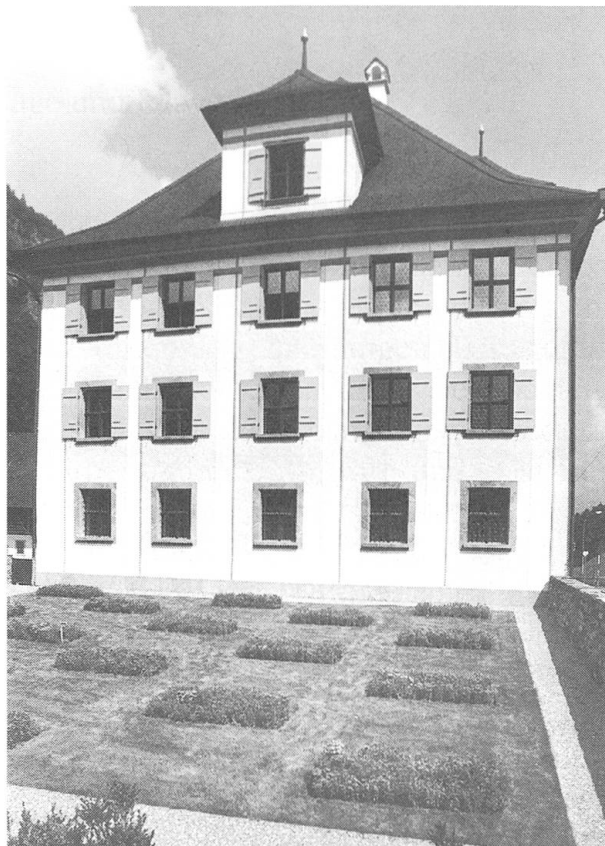
Nach einer umfassenden Renovation erstrahlt das Herrenhaus wieder im alten Glanz. Ebenfalls neu gestaltet wurde der Barockgarten.
