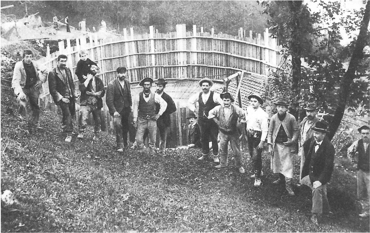
Das Reservoir Napf. Es wurde 1902... erbaut und hat mit einem Durchmesser von 20 Metern ein Fassungsvermögen von 1260 m 3 .
