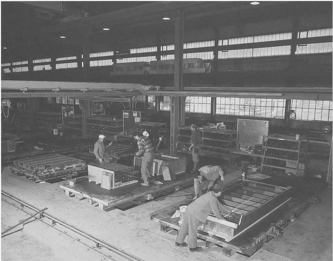
Bei der Element-Fertigung wird die Schalung vorbereitet und die Armierung verlegt.
