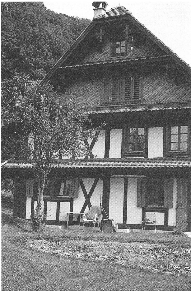
Bauernhaus Lochmatt (Josef Niederberger, Holzbau, Büren).
