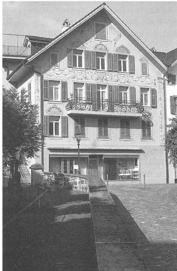
Haus Nägeligasse 3: Aussenansicht mit der erneuerten Fassadenmalerei (Jörg Feierabend, Architekt, Stans)
