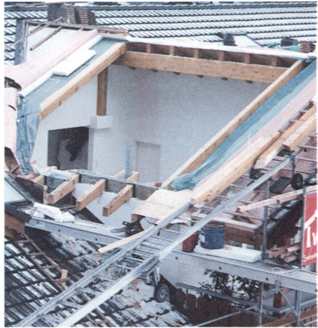
Dachreparatur nach Lothar
