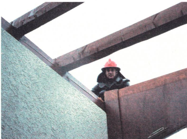
Feuerwehr Emmetten deckt Dächer ab.
