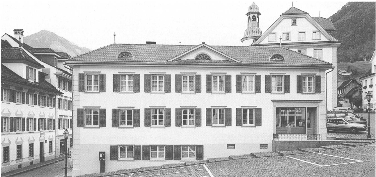
Haus Leu mit neuer Fassade.
