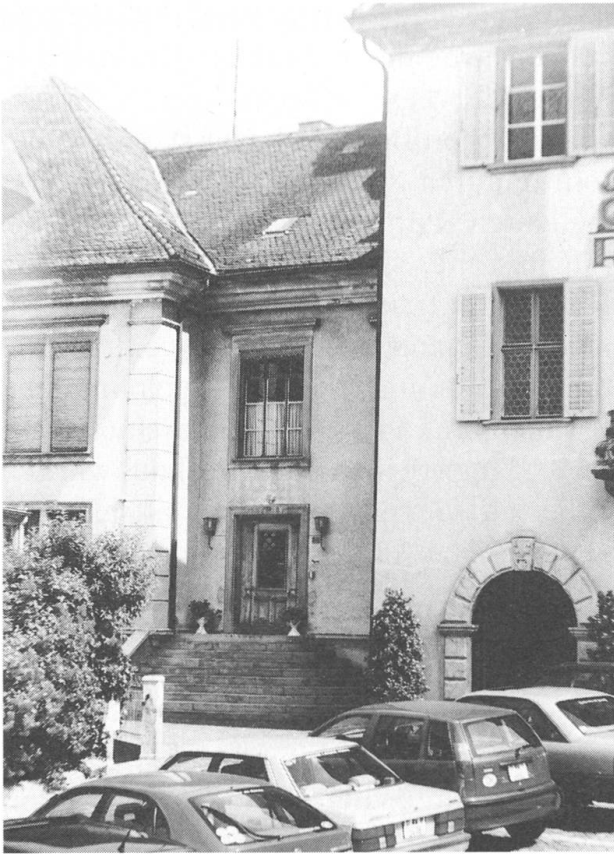
Verwaltungsgebäude und Zwischentrakt vor der Sanierung.
