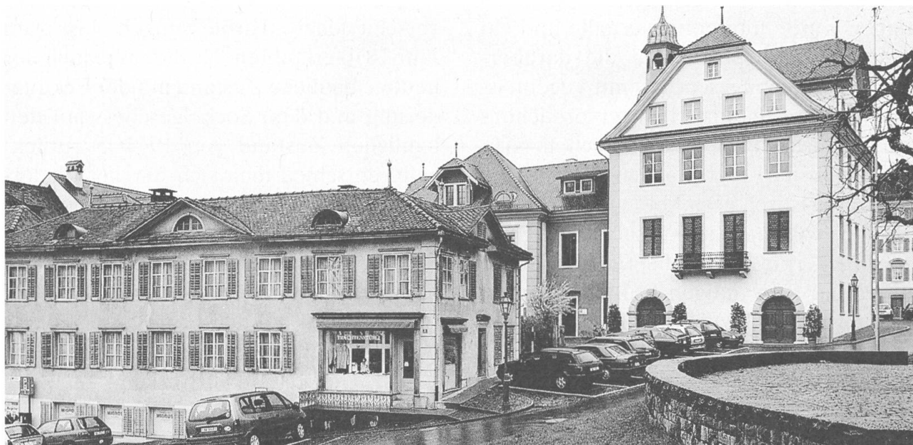
Haus «Leu» vor der Sanierung.
