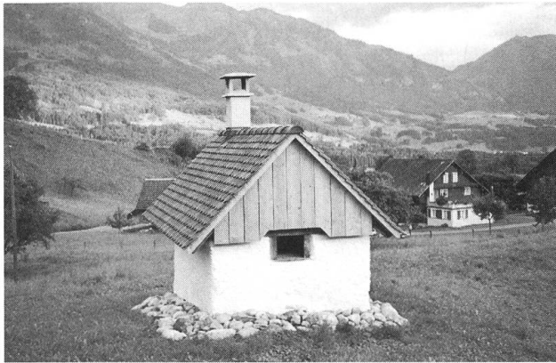
Ennetmoos. Dörr- und Backhaus «Gruobli», Mueterschwandenberg. Ansicht von Norden.
