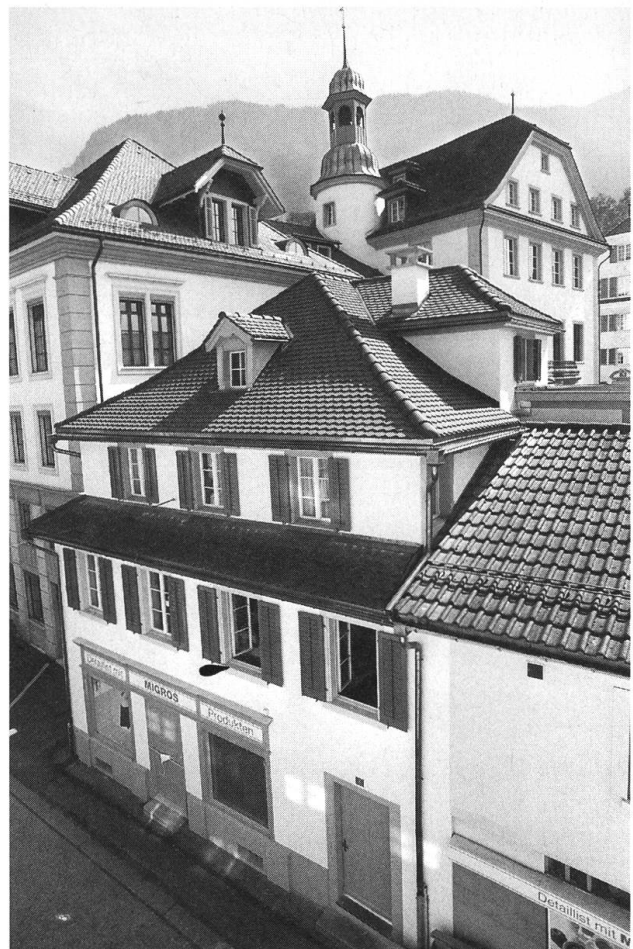
Stans. Wohnhaus Rathausplatz 9 (Wammersches Haus). Ansicht von Norden. Zustand nach der Restaurierung.
