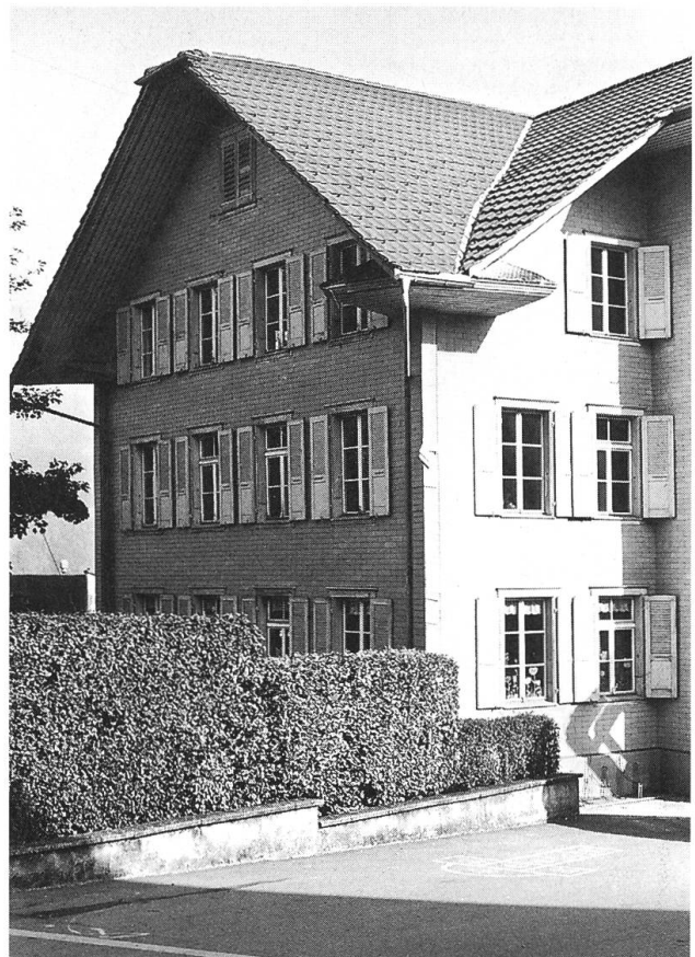
Buochs. Altes Schulhaus. Ansicht von Südwesten.
