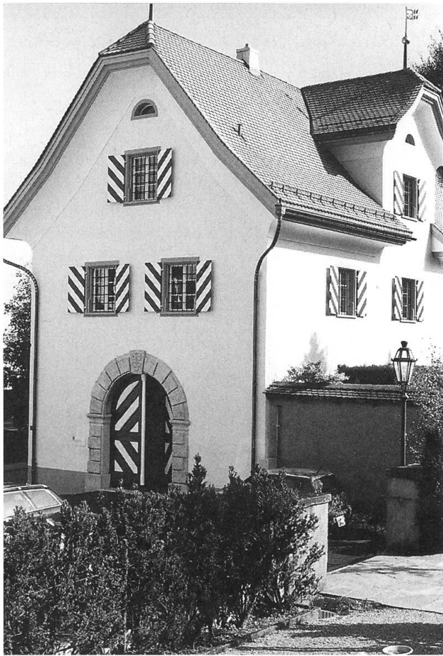
Stans. Altes Zeughaus, Mürgstrasse 12. Aussenansicht nach Restaurierung
