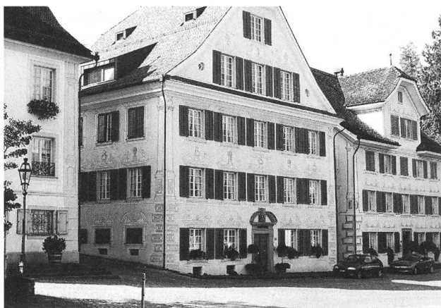
Stans. Zelger-Haus, Rathausplatz 7. Aussenansicht nach der Restaurierung.
