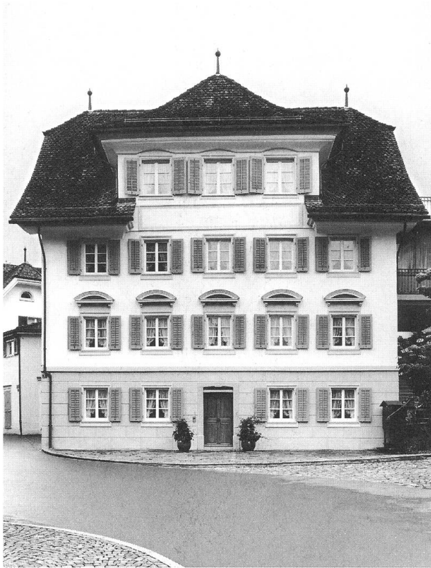
Ansicht von Westen nach der Restaurierung.
