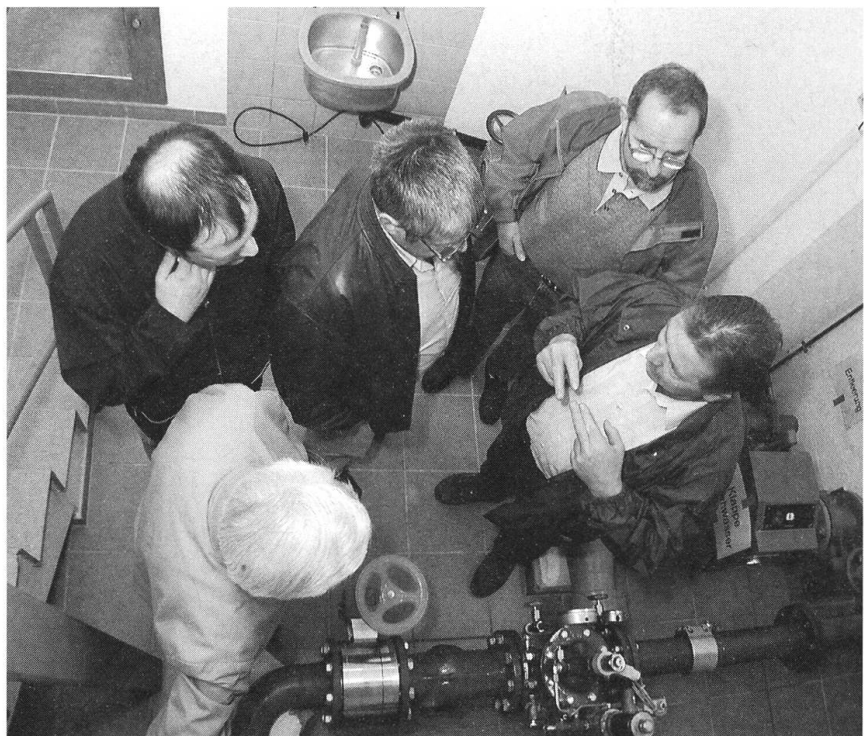
05.06. Neue Wasserversorgung Oberrickenbach eingeweiht
