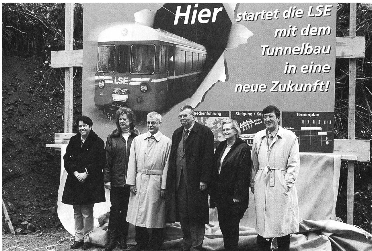
16.03. Spatenstich Bahntunnel der LSE nach Engelberg
