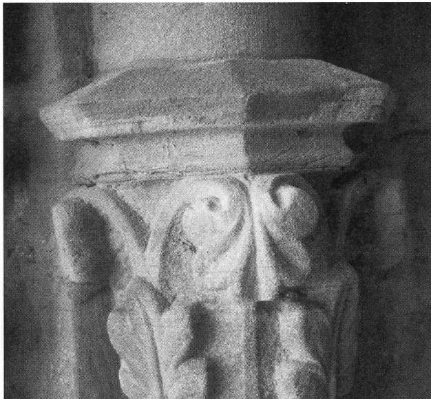
Stans, Winkelrieddenkmal. Restaurierungsmassnahmen: Aufmodellierungen an bauplastischen Werkstücken (oben: vorher, unten: nachher)
