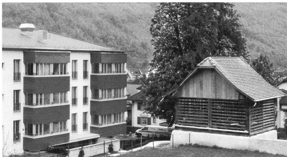
Stans. Stallgebäude des Kayserhauses an der Nägeligasse. Vorher (oben), nachher (unten)
