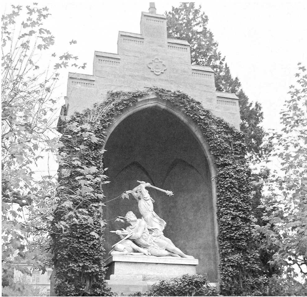
Stans. Winkelrieddenkmal, Restaurierung
