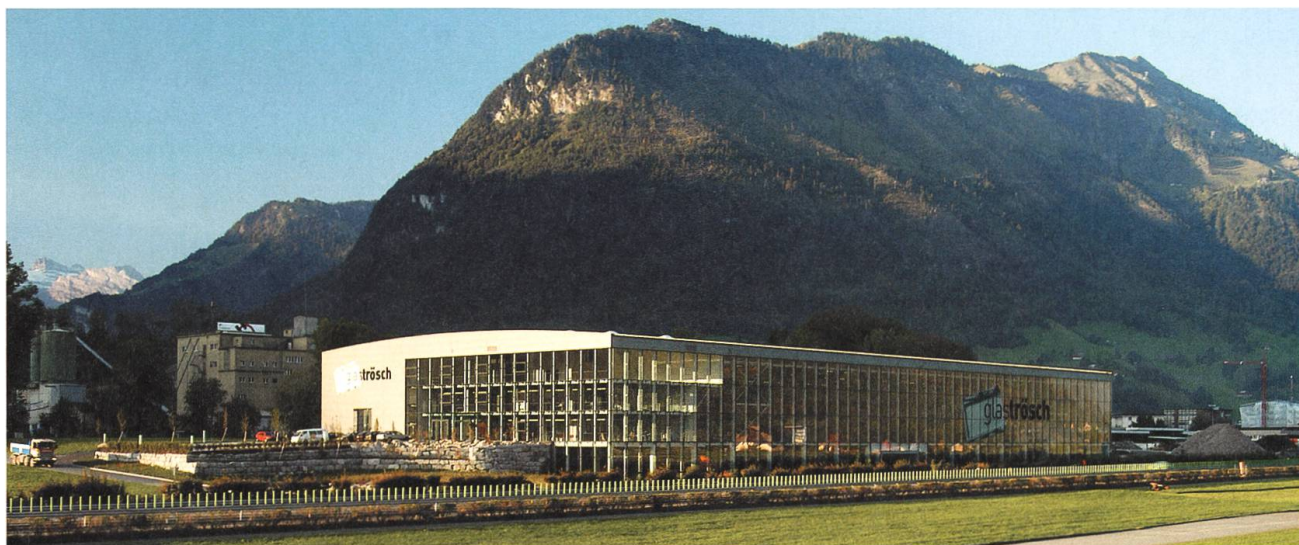
Das neue Produktionswerk in Buochs
