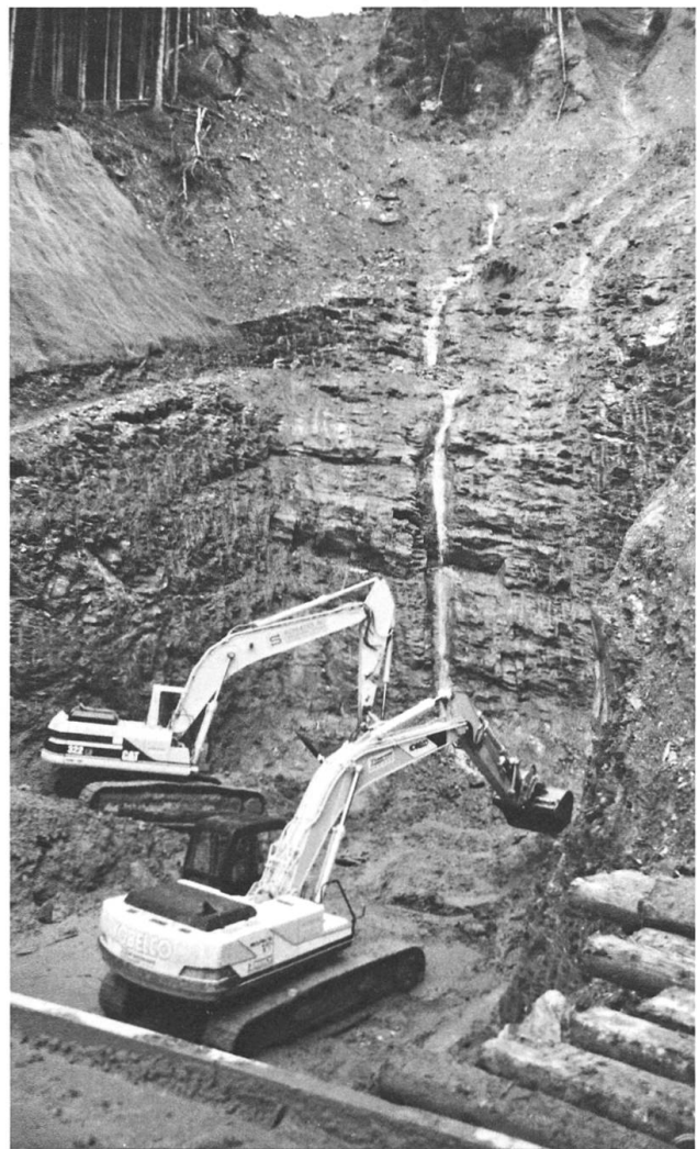
Bagger räumen den durch Sprengung des Felsens auf das Zehnfache vergrösserte Sammler Hinter-Erlibach III
