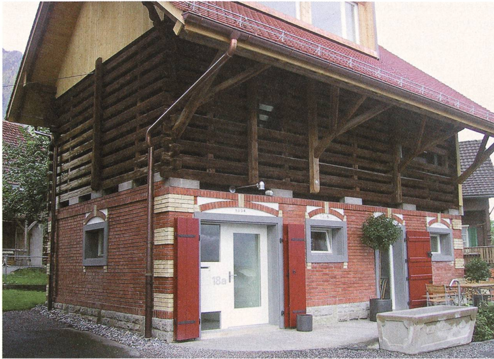
Beckenried, Ökonomegebäude Rütistrasse 18. Aussenansicht von Nordosten. Zustand nach dem Umbau
