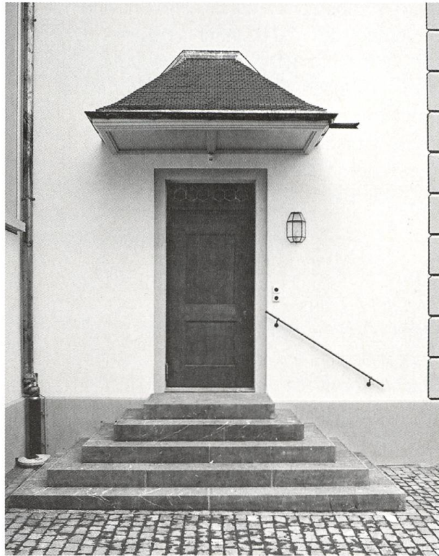
Beckenried, Pfarrkirche St. Heinrich, Ansicht des neu gestalteten Sakristeieinganges auf der Ostseite der Kirche
