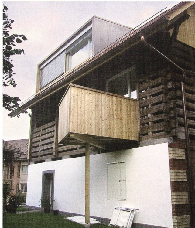
Beckenried, Ökonomegebäude Rütistrasse 18. Aussenansicht von Süden mit der neu hinzugefügten Dachlukarne und dem Balkonanbau
