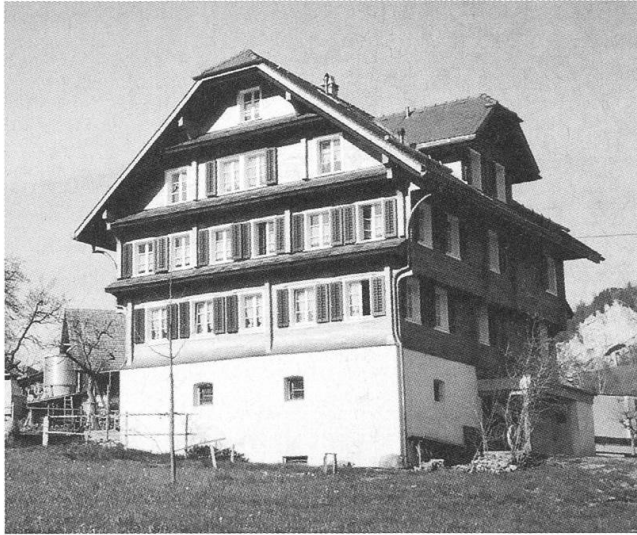
Ennetmoos, Bauernhaus Hostatt. Ansicht von Südosten. Zustand nach der Restaurierung
