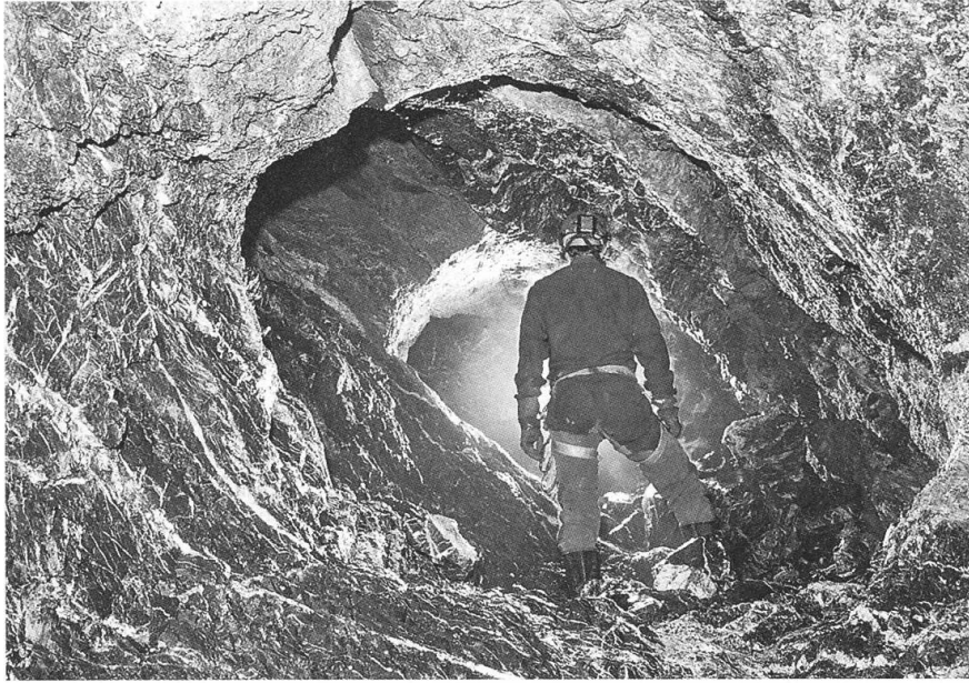
11.12. Mit Spritzbeton gegen die Natur.
