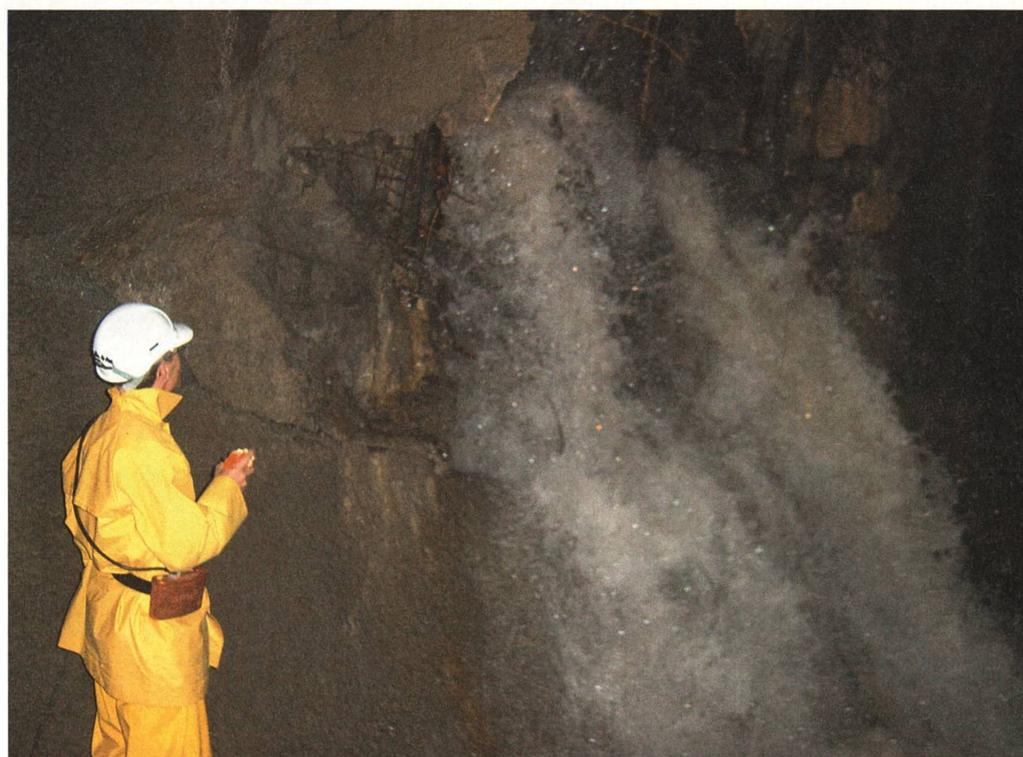
Nach den schweren Unwettern am 22. August 2005 hat der druckhaltige Ausbau des Gewölbes bei der Tunnelklufthöhle nicht Stand gehalten. Beim nun bereits dritten Wassereinbruch ergiesst sich anfänglich schätzungsweise 700 l/s Wasser in den Tunnel.
