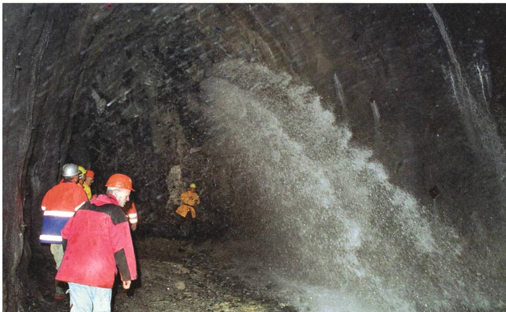
Nach 1,7 km im Tunnel-Nordvortrieb wurde die Quintner-Kalk-Zone erreicht. Das Wasser schoss aus vier Bohrlöchern bis 22 m weit in den Tunnel.
