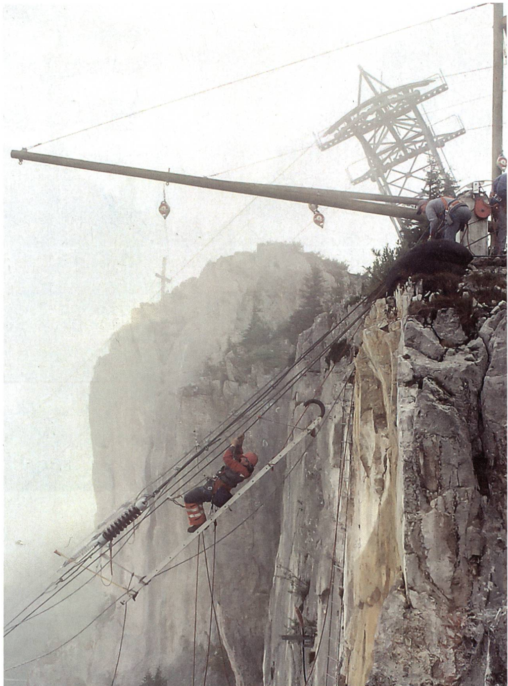
EWN-Gebirgsbaustelle Musenalp. Versorgung abgelegener Gebiete.
