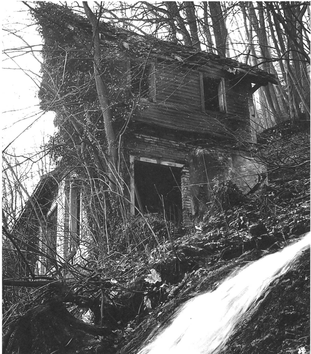
Generatorhaus des ehemaligen EW des Hotel Schöneck, Emmetten.
