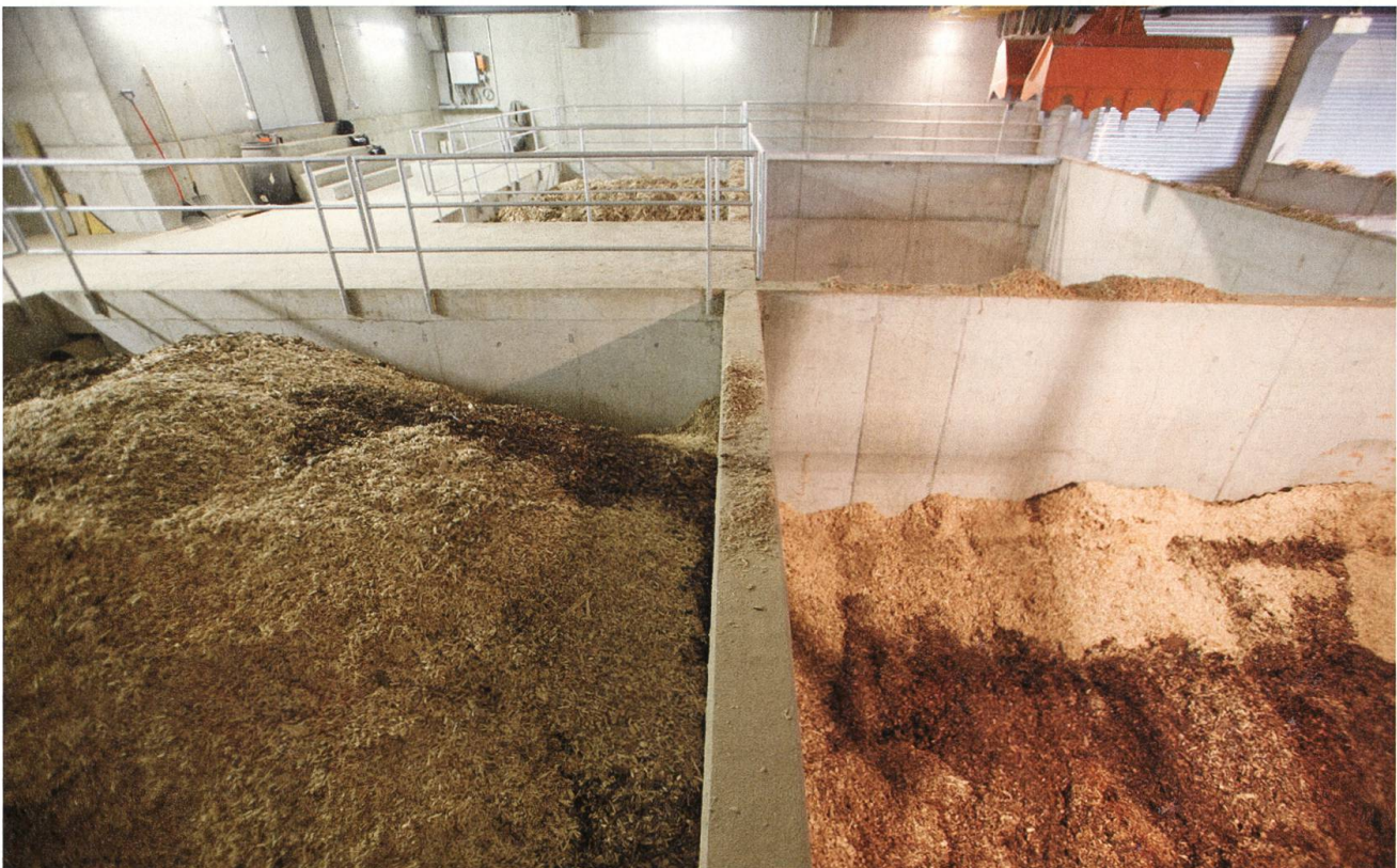
Blick ins Schnitzellager mit den Schubböden und dem ferngesteuerten automatischen Kran, der das Schnitzellager «bewirtschaftet».
